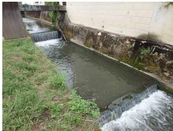
Afb.21 Het sluiswerk aan de Graetmolen.
