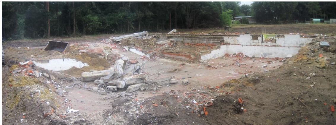
Zicht op de kelder van de zuidelijke woning tijdens de afbraak.
