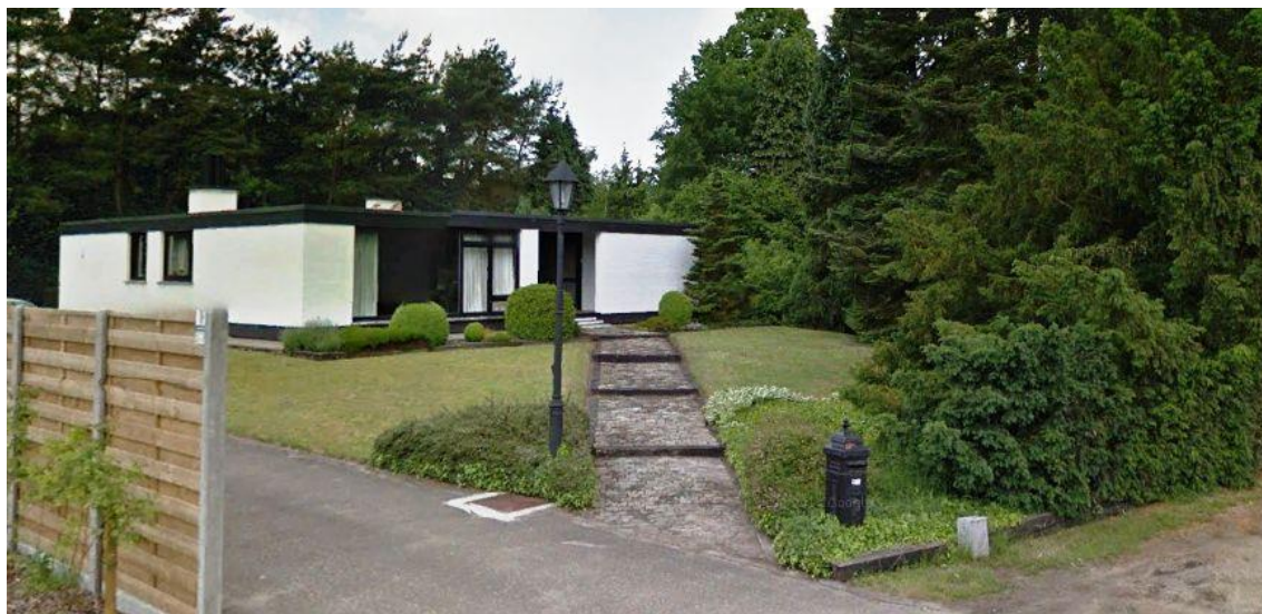
De zuidelijke woning voor de afbraak; de trappen naar de hoofdingang geven het niveauverschil aan ten opzichte van het achter en naast liggende maaiveld.
