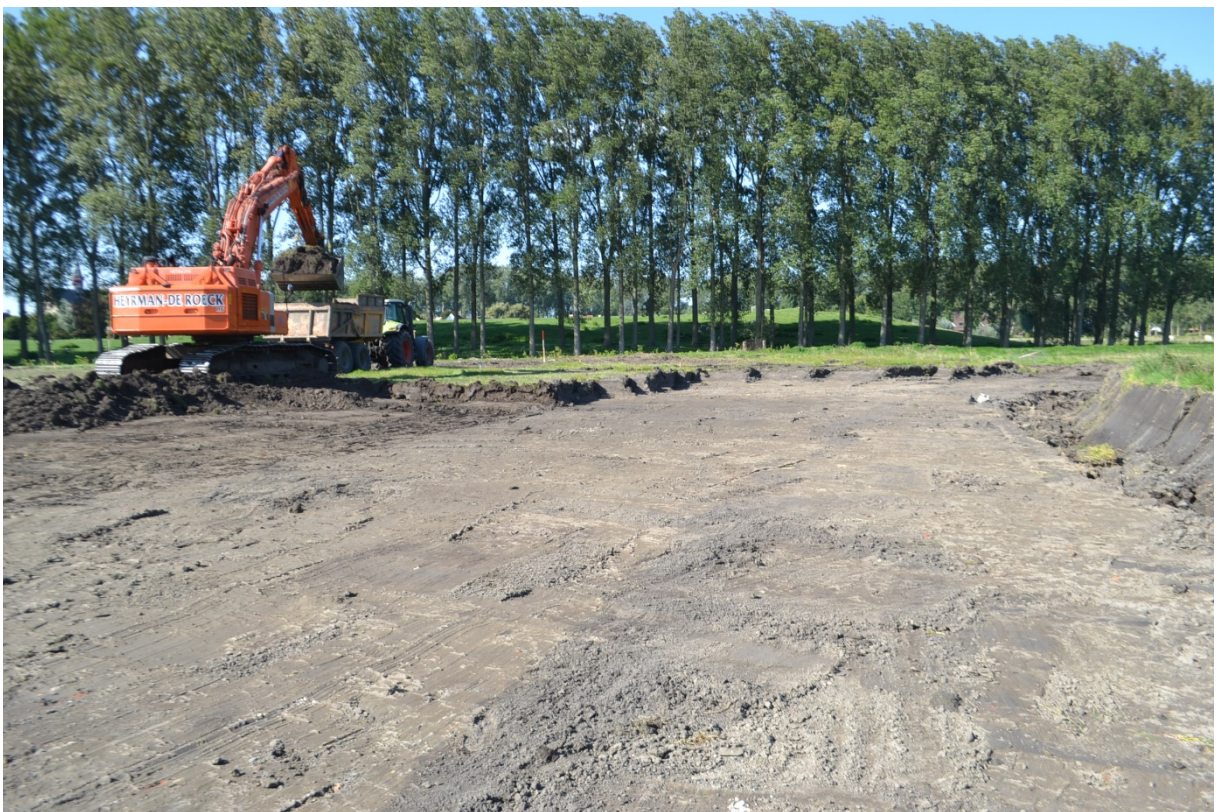
Fig. 20 Zone 1, richting west
