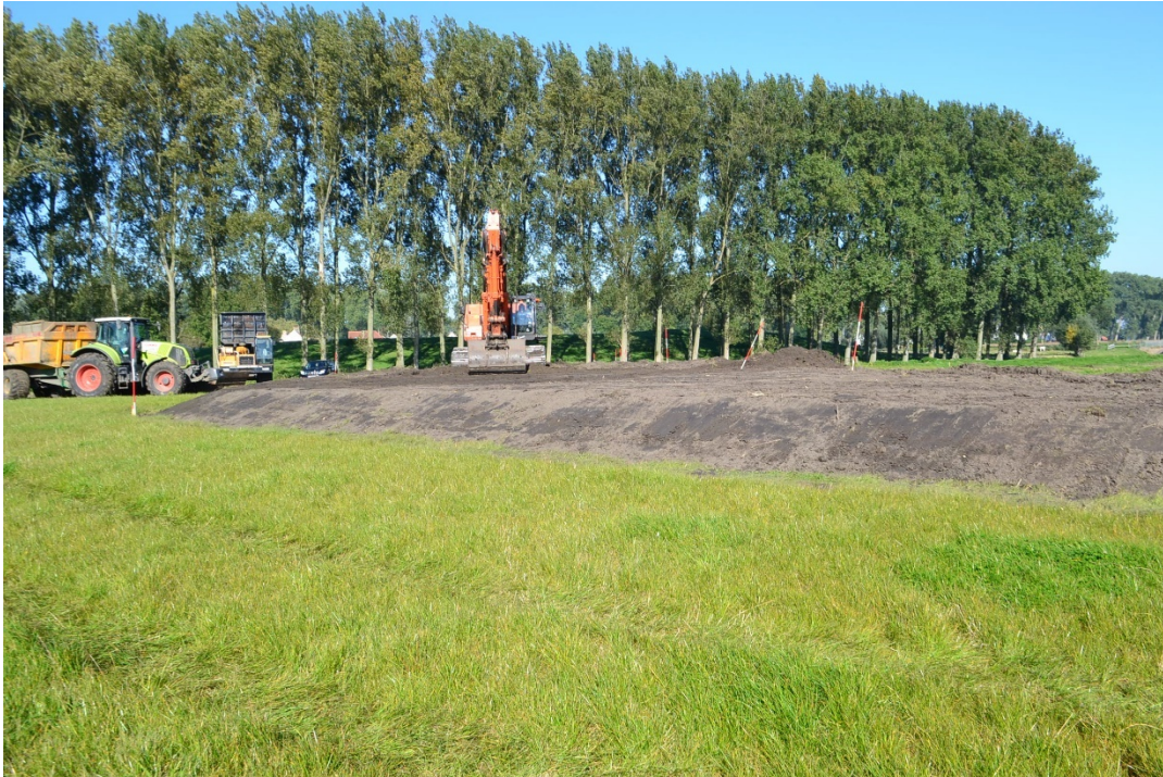
Fig. 23 Ophoging van het aarden lichaam in zone 1
