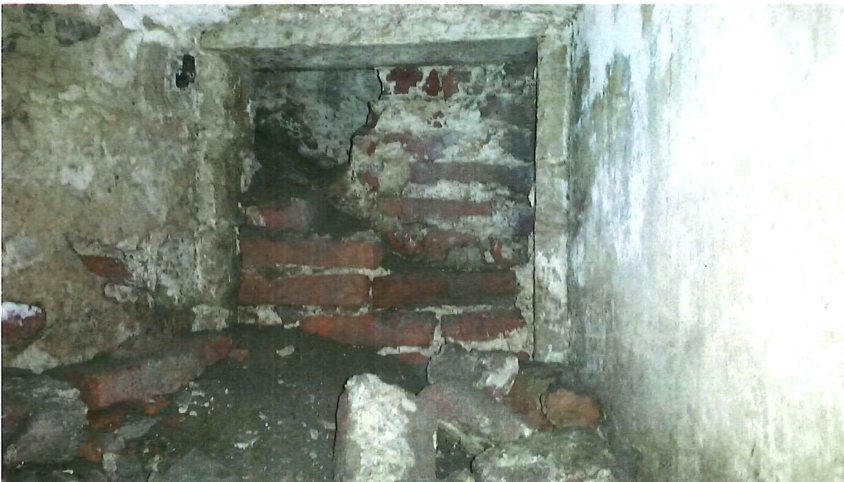
Foto 7 In de overwelfde ruimte bevindt zich een dichtgemetselde deuropening.
