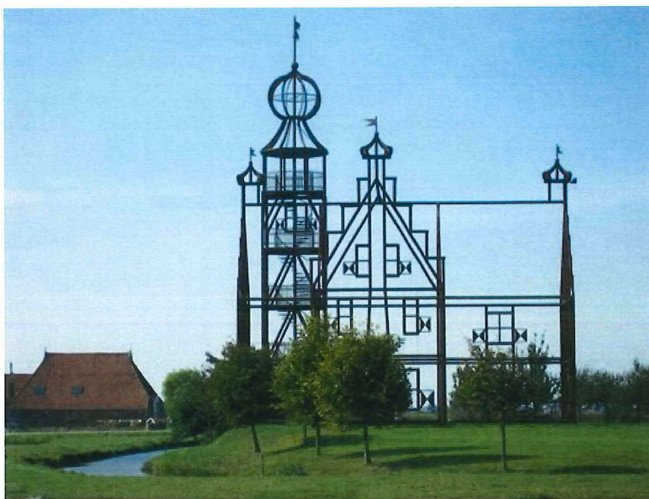
Figuur 58 Unistate, Beers, Friesland, In een open stalen constructie is na geofysisch en historisch onderzoek deze state gevisualiseerd.
