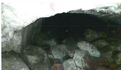
Figuur 20 doorgang naar de tweede overwelfde ruimte
