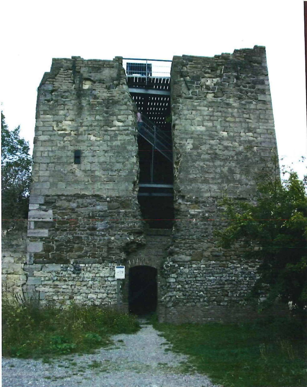
Figuur 59 Hoeve Lichtenberg, Maastricht, Staalskelet binnen in toren.
