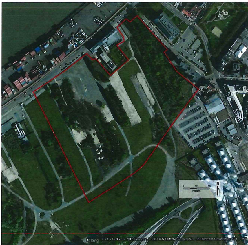
Figuur 4 Luchtfoto met locatie van het studiegebied (het noorden ligt bovenaan): de zuidelijke zone situeert zich in de toekomstige groenzone: deze is voor het bureauonderzoek meegenomen in de studie. Gezien de beperkte ontgravingen die hier gepland zijn, zal deze echter niet meegenomen worden in het veldwerk. (Luchtfoto: http://www.worldmapfinder.com/BingMaps/NL_Europe_Belgium_Antwerp.html )
