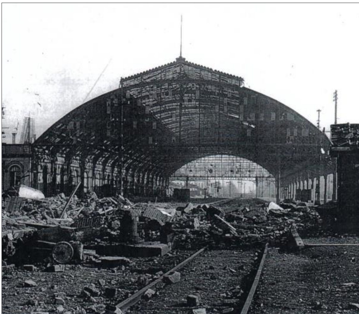
Figuur 22: Een zwaar beschadigd station na een Engels bombardement (april 1918) 39
