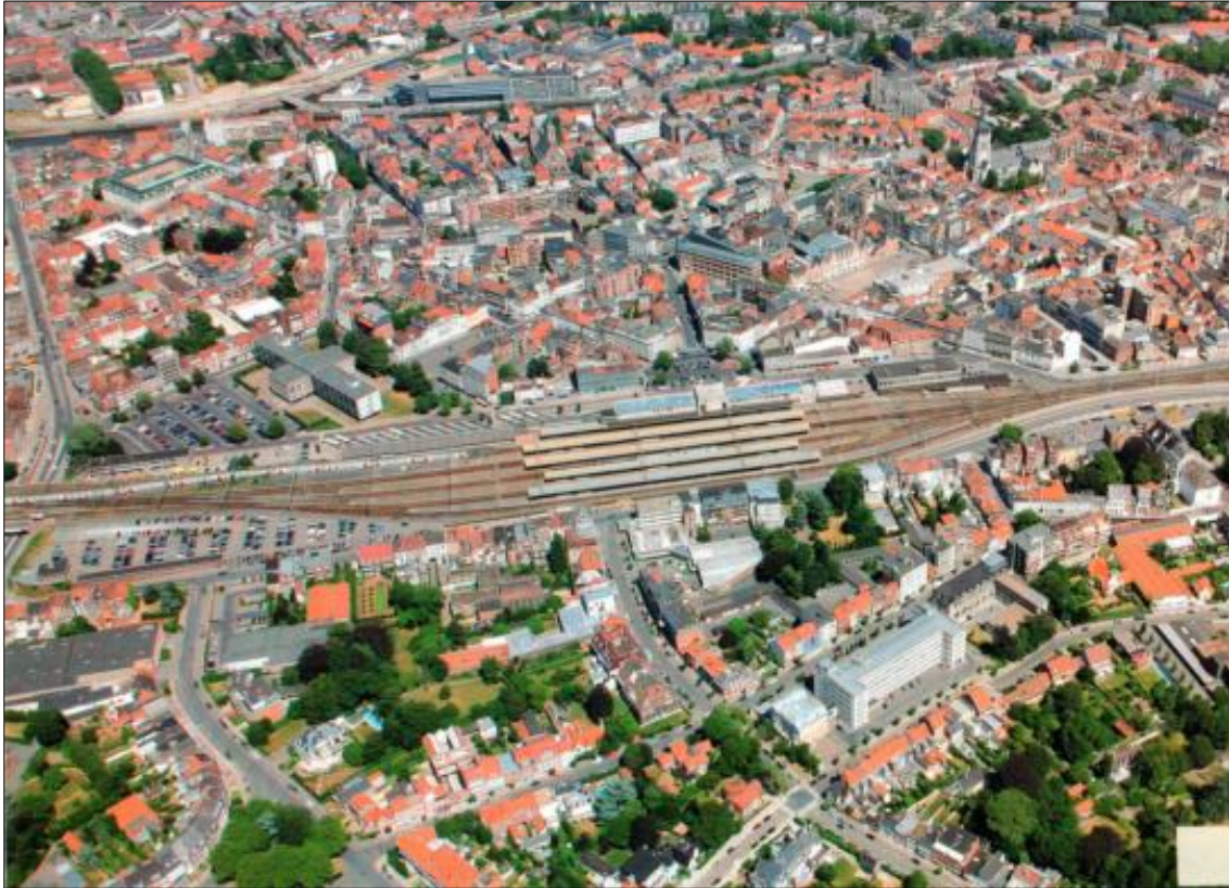
Figuur 27: Zicht op het station, de parking en Zandstraat (uiterst links)(2010) 49
