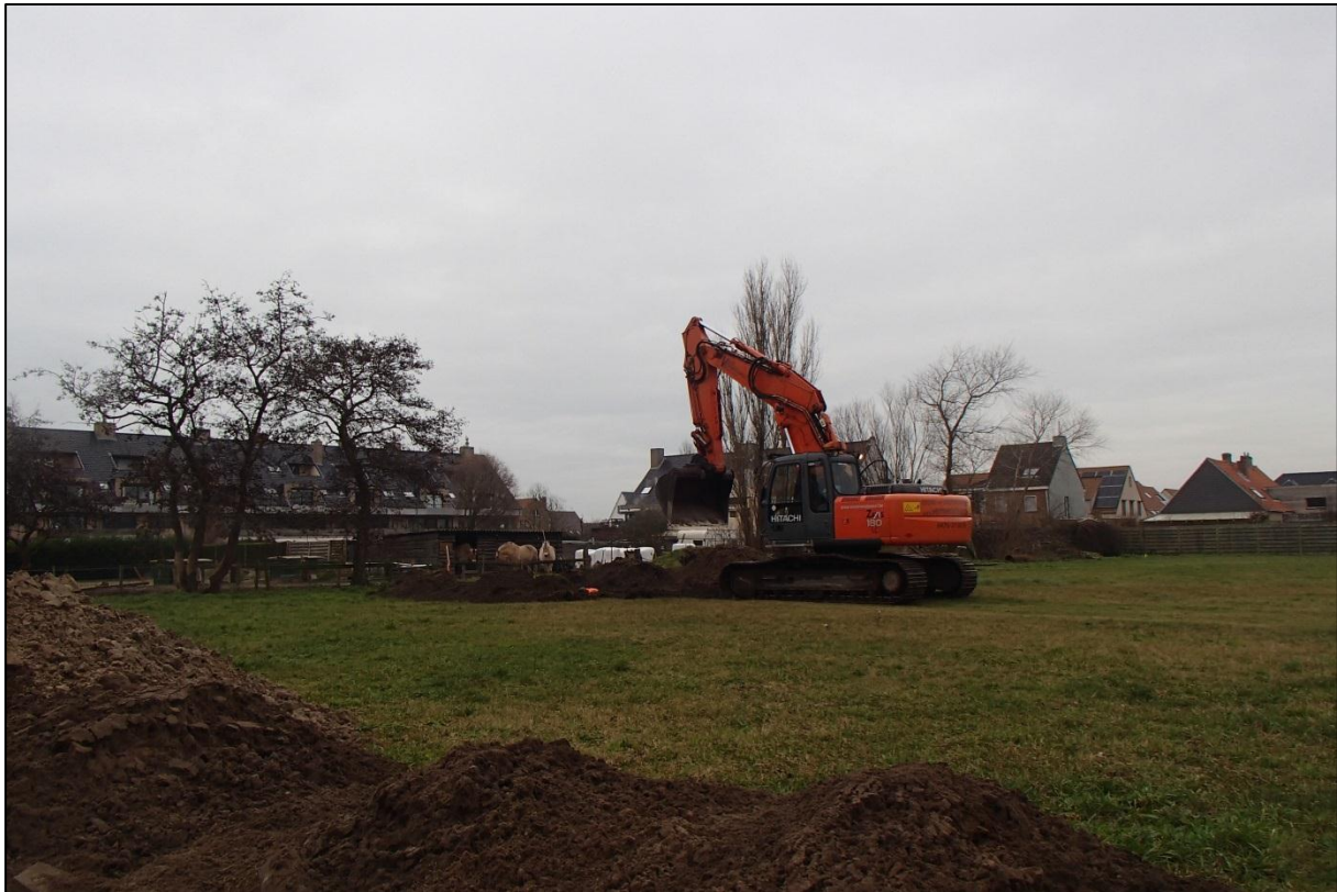
Figuur 14: Aanleg van de proefsleuven.
