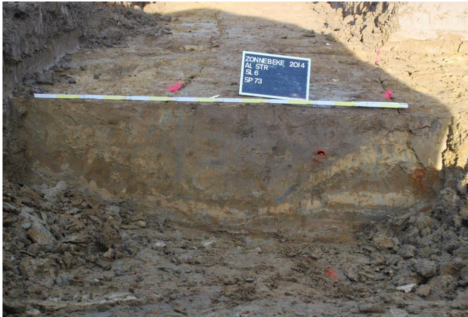
Fig. 30 : fotografische opname van SP 73 (SL 6) met drainage in doorsnede
