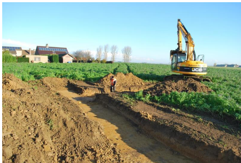
Fig. 18 : fotografische opname van de aanleg van een kijkvenster (uitbreiding op de sleuf).
