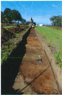
Figuur 11 Aanleg van een sleuf.
