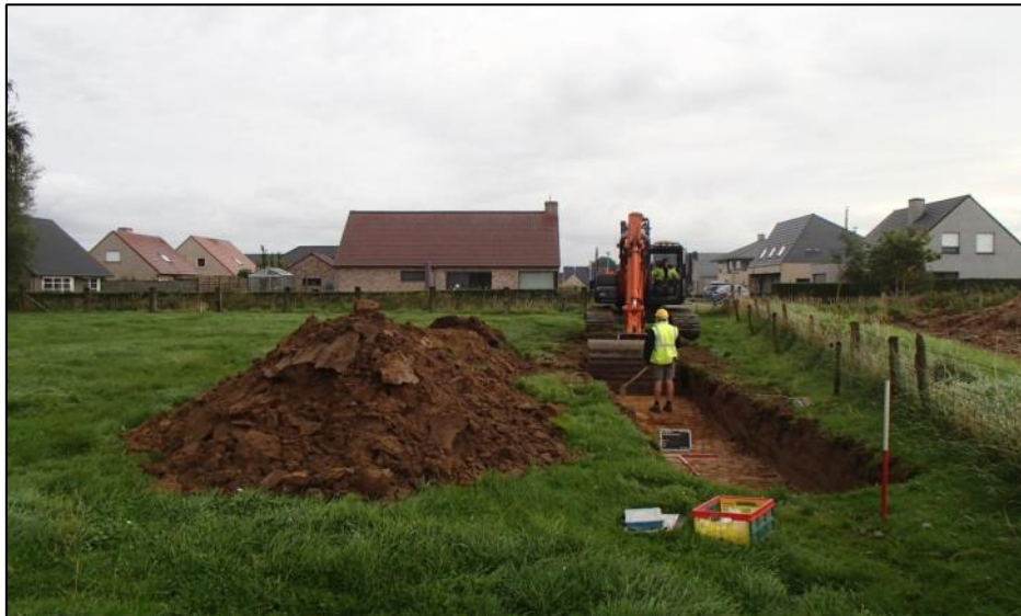
Figuur 15: aanleg van de proefsleuven.
