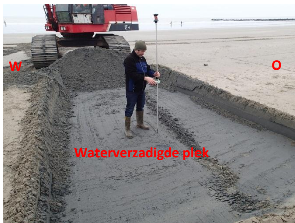
Werkput 2 ter hoogte van anomalie A2 & C2 inmeten waterverzadigde plek
