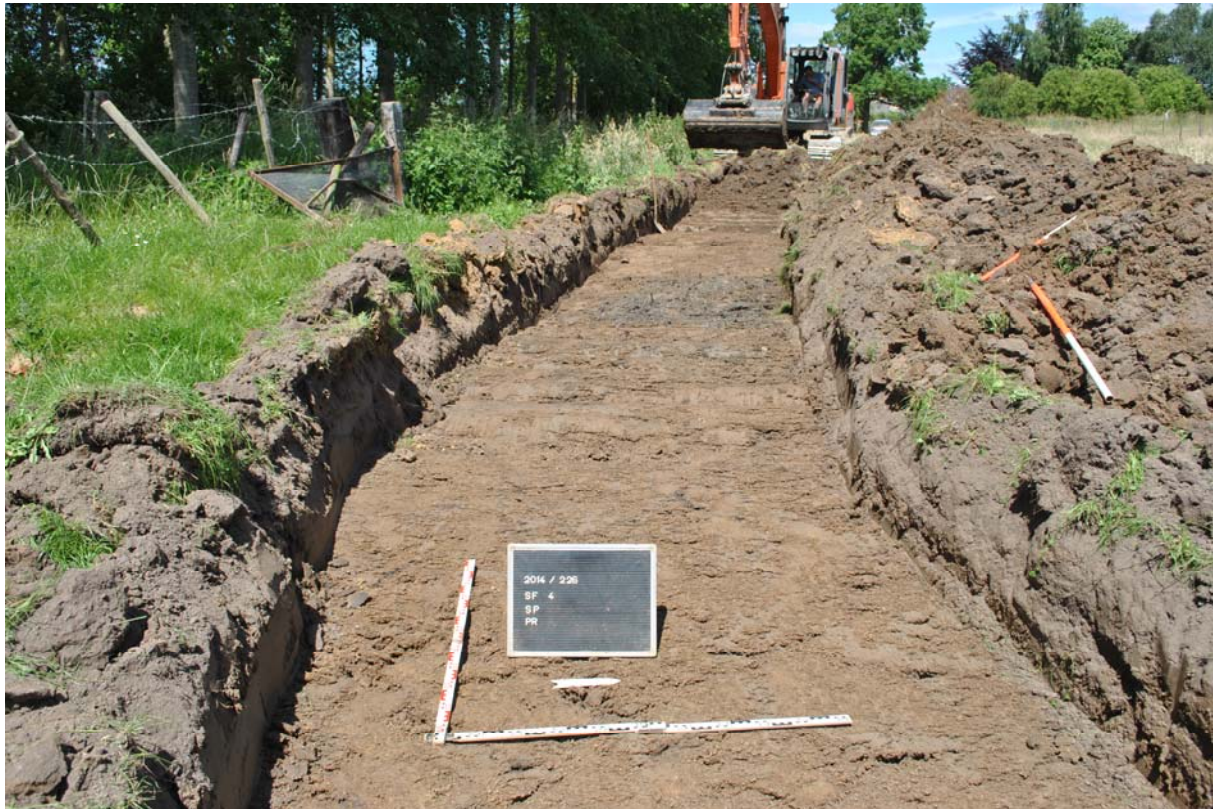
Fig. 2.1: Aanleg van het vlak.
