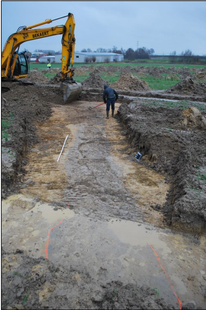
Fig. 14 : aanleg volgsleuf op spoor 7
