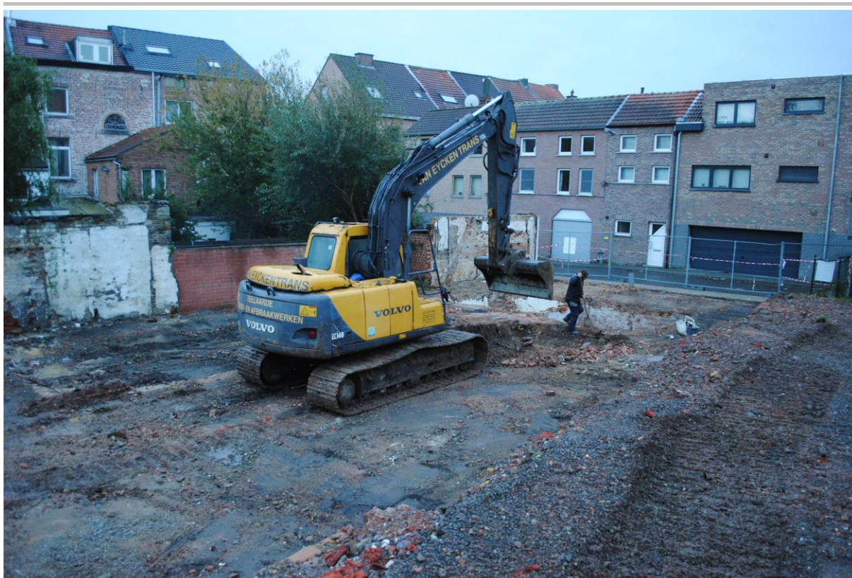
Fig. 2.2: De aanleg van werkput 2.
