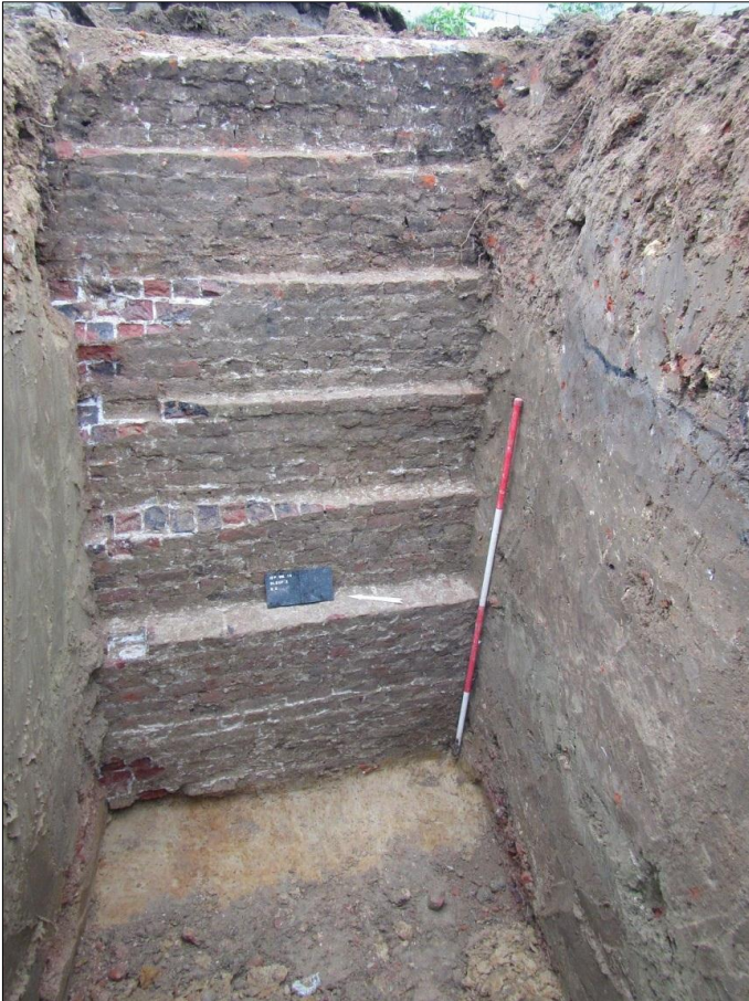
Figuur 36. Ter hoogte van S3 kon vastgesteld worden dat de buitenmuren zwaar gefundeerd waren
