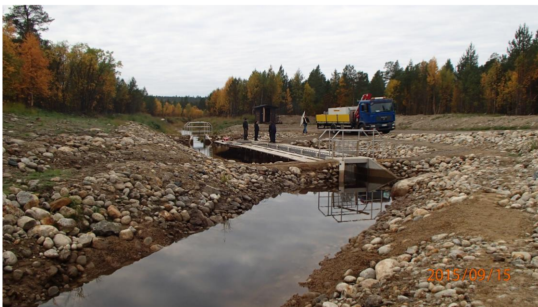
Tuolpujärven luonnonravintolammikon uusi siian poikasten keräilylaite. (Kuva: Erno Salonen).
