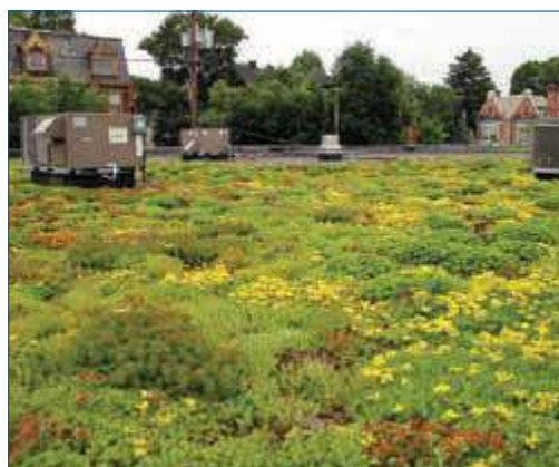
13.10. att. Zaļie jumti ir ne tikai estētiski pievilcīgi un atdzīvina pilsētvidi, bet arī palīdz saistīt piesārņojumu pilsētās un paaugstināt ēku energoefektivitāti.
