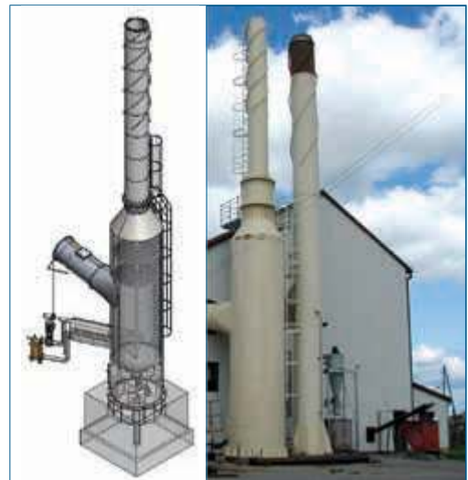
8.11. att. Ludzas koksnes šķeldas katlu mājas dūmgāzu kondensatora shēma (pa kreisi) un katlu māja (pa labi).
