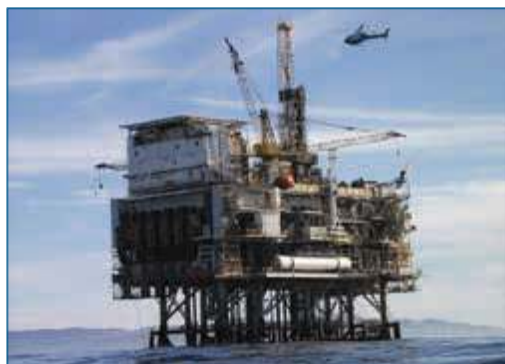
16.2. att. Naftas platforma Ziemeļjūrā.
