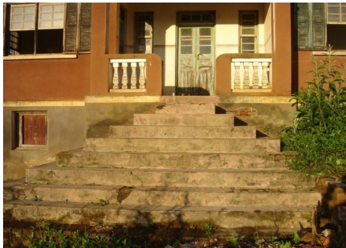
Figura9: Escada de acesso à casa e à varanda
