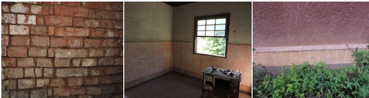
Figura8: Detalhes da construção, o uso de terra e água para a edificação das paredes. Ao centro detalhe da Escaiola na cozinha, na direita parede externa com chapisco
