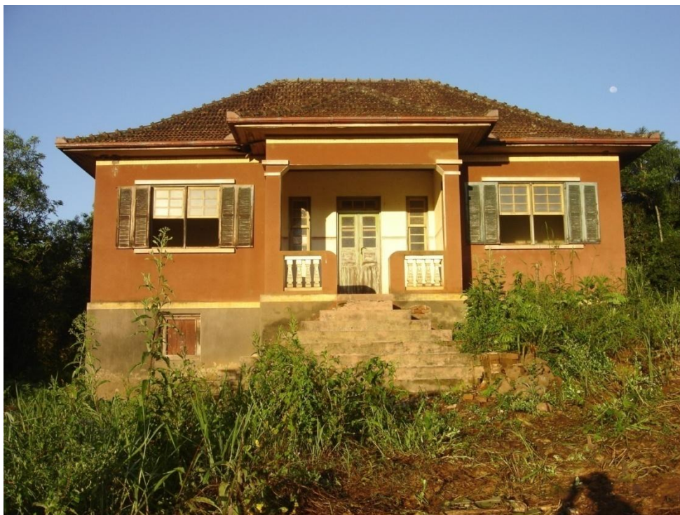
Figura 1: Casa da Família Hepp, data de construção: 1953
