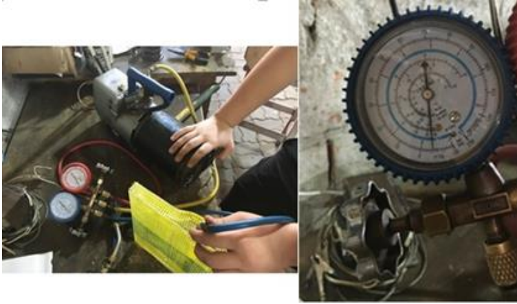
Figura 16 – Método utilizado para o vácuo
