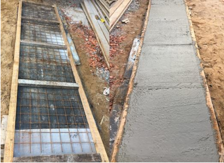
Figura 19 – Execução das lajes
