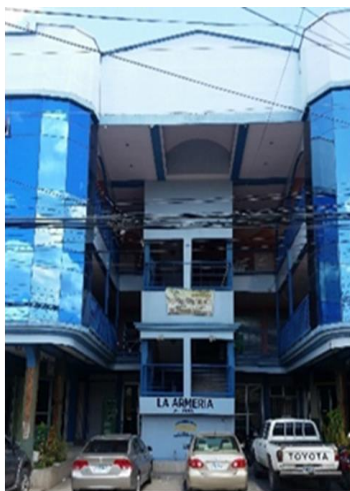
Edificio ADED Valle. Nacaome. Fuente: Tomado de archivo de la ADED Valle (2017)
