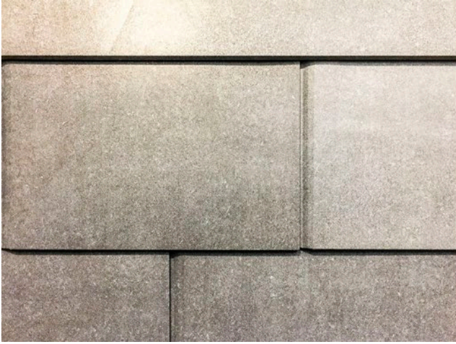
08 | a) prototipo realizzato in alluminio verniciato (l'immagine mette in risalto l'effetto cromatico e delle ombre ottenuto grazie al sistema delle pieghe). b) prototipo ottenuto da stampa 3D (particolare delle connessioni tra i vari elementi) a) prototype in pre-painted aluminium (the image underlines the effect of colouring and shadow given by the system of folds). b) 3D printed prototype (detail of the connection between several elements)
