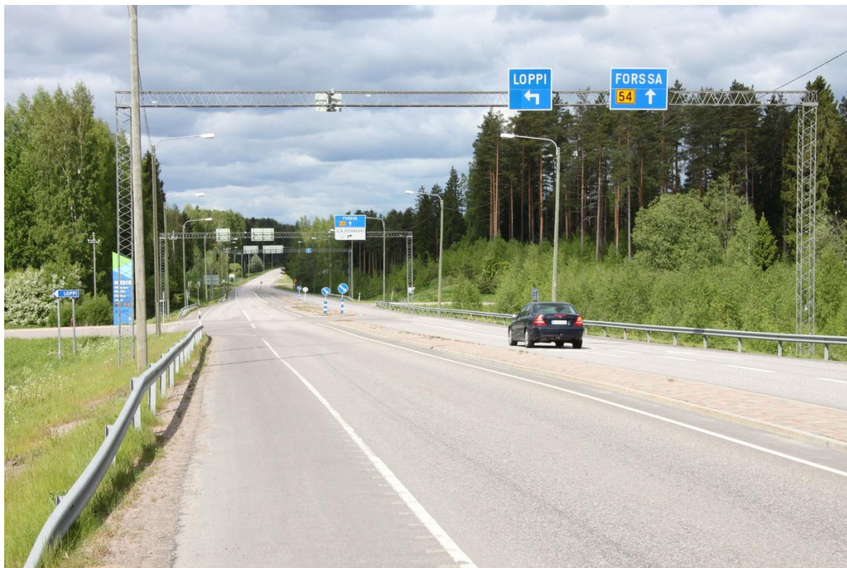
Kuva 10. Kantatien 54 ja Yhdystien (mt 13609) nykyinen korokkein kanavoitu tasoliittymä. Eritasoliittymän siirtopaikka on esitetty kuvan auton oikealle puolelle tiekaiteen taakse, Yhdystien linjalle.
