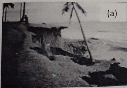
Gambar 1(a). Tanah longsor di Lais, Bengkulu Utara.
