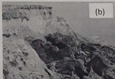
Gambar 1(b). Tanah longsor di Serangai, Bengkulu Utara.
