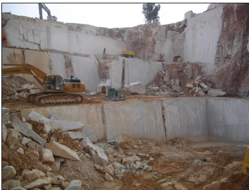
Figura 236- Frente de exploração em Casal Farto onde é apreciável o espaçamento da família NW-SE. Esse espaçamento, na ordem dos 5 m, é bastante reduzido face à ausência de descontinuidades mecânicas sub-horizontais num corpo sedimentar maciço com espessura superior a 15 m. Porém, em termos do aproveitamento económico para blocos de rocha ornamental, é um espaçamento que se pode qualificar de muito bom.
