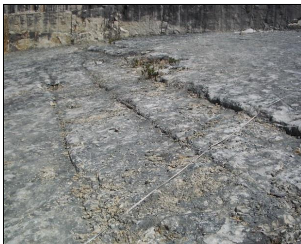
Figura 155- Estratificação rejeitada ao longo de diaclases reativadas
