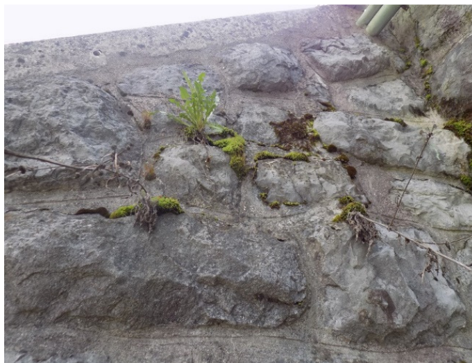
Slika 13: Zid, ki podpira most.
