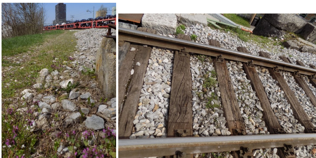
Slika 14 in slika 15: Okolica železniške proge in železniška proga.
