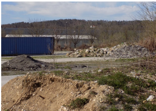
Slika 2: Opuščeno gradbišče v industrijski coni.
