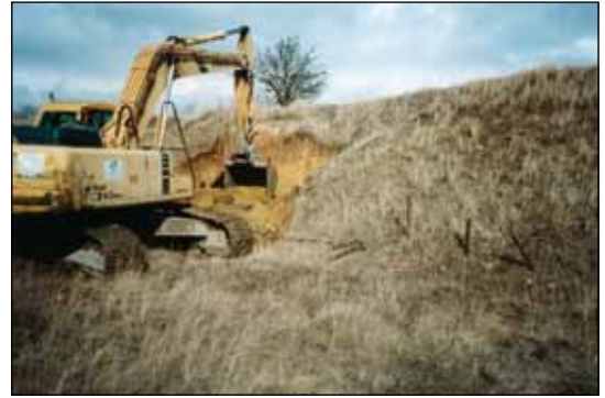
Abb. 16: Anlage einer neuen Steilwand im Tagebau Amsdorf. Foto: R. Ortlieb.
