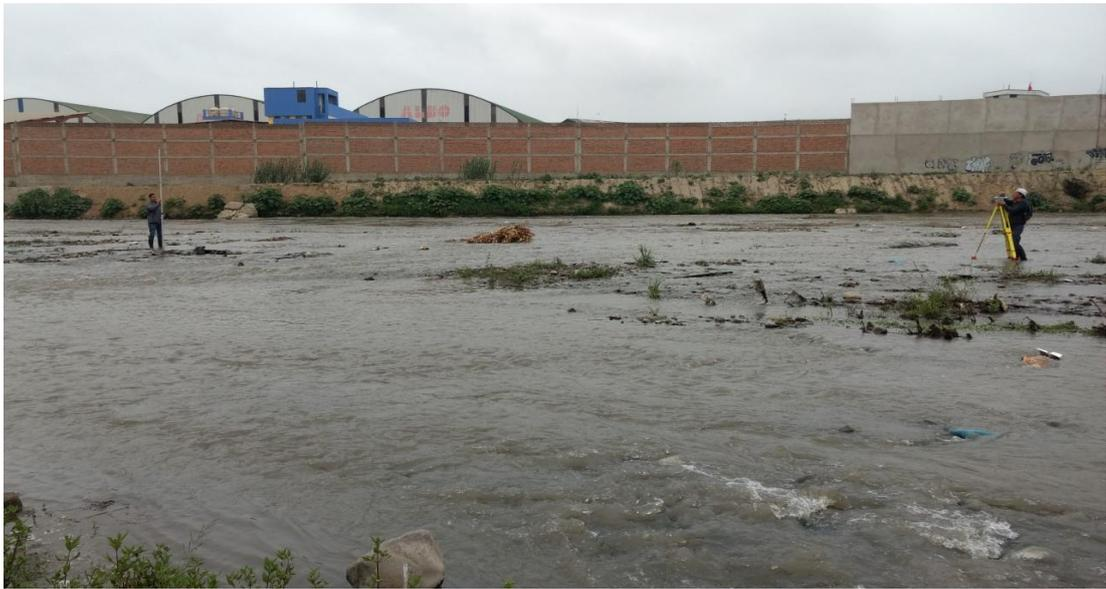
Figura 32. Trabajo de nivelación en el lecho del río Moche (Fuente: Elaboración propia)
