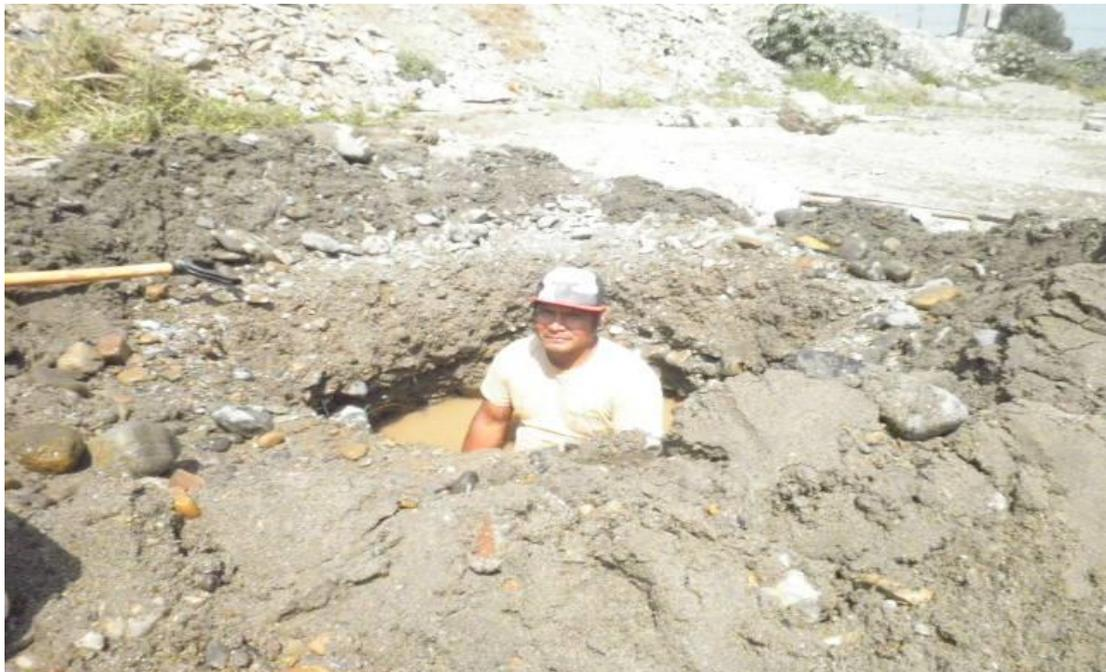
Figura 21. En la presente imagen observamos como la persona contratada realiza el trabajo de las calicatas, se muestra la presencia de agua proveniente del río la cual tuvimos que ir evacuando por medio de una bomba manual como vemos en el (Anexo 4).
