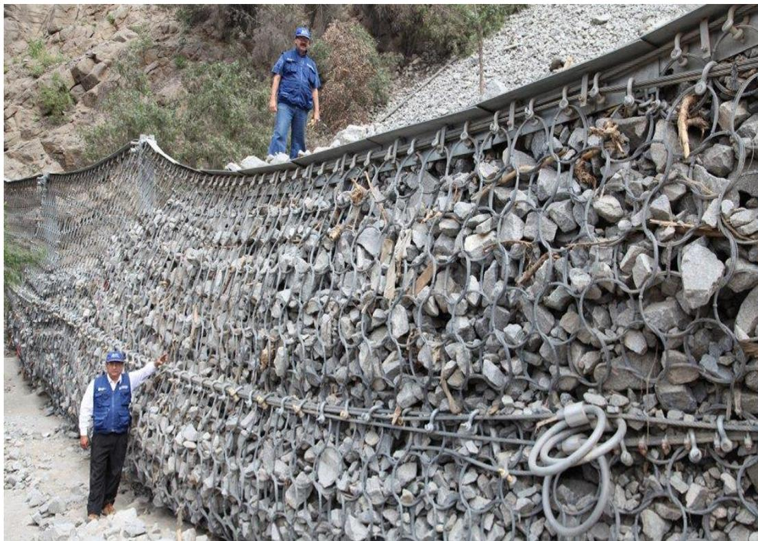
Lugares del cauce principal de la cuenca de San Idelfonso donde se podrían colocar muros transversales y mallas dinámicas para retener rocas y sedimentos.
