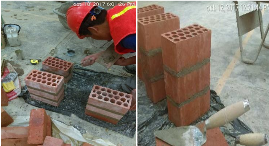
Figura 58. Elaboración de las pilas de unidades de arcilla industrial
