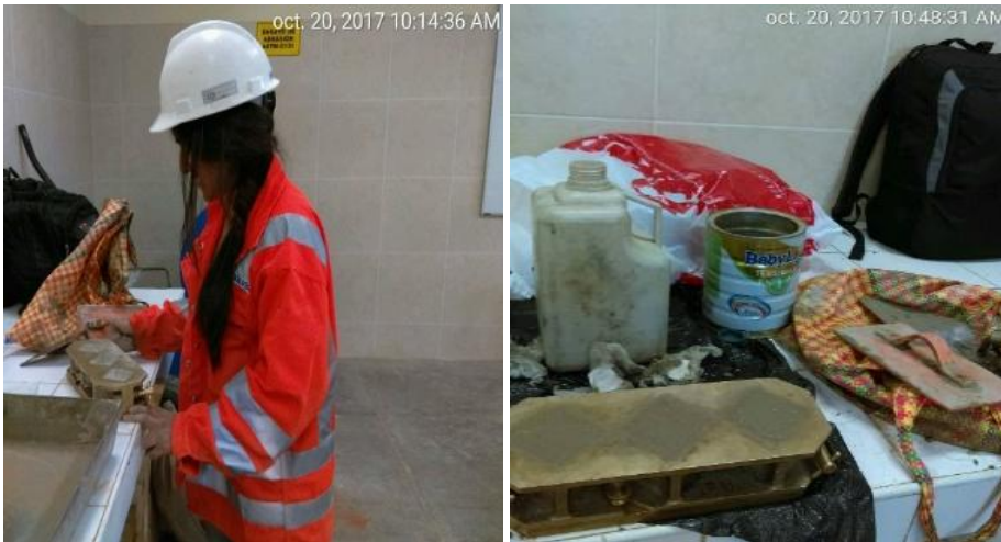
Figura 61. Colocación de mezcla de mortero sin cal en el molde
