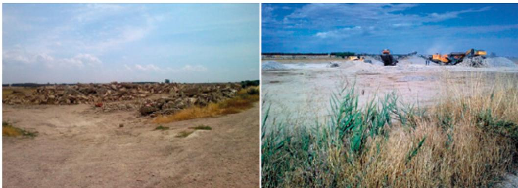
**Figura 13.** Materiales retirados de la antigua red de acequias en hormigón (izquierda) y su posterior procesamiento (derecha) para convertirlos en zahorra para los nuevos caminos en Almodúvar (julio 2009). Ambas imágenes están tomadas en la misma ubicación.
