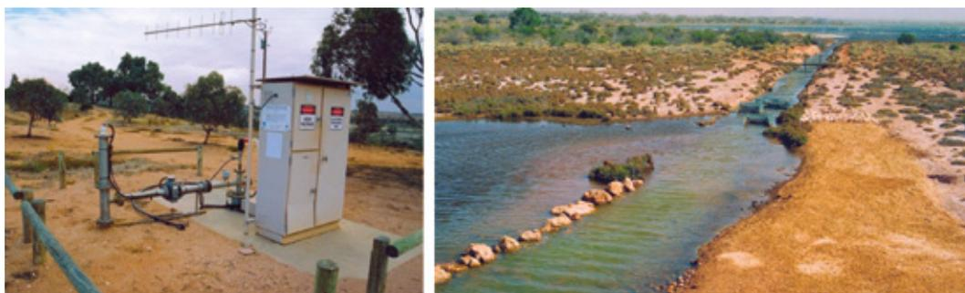
**Figura 8.** Sistema de intercepción de sales (Salt Interception Scheme) en Australia del Sur: Estación de bombeo en Waikerie junto al río Murray (izquierda) y laguna artificial de Stockyard Basin. Una red de bombes como el de la imagen capta las aguas subterráneas muy salinas que fluyen hacia el río Murray (en la foto al fondo) y las conducen hasta la laguna de Stockyard (derecha).
