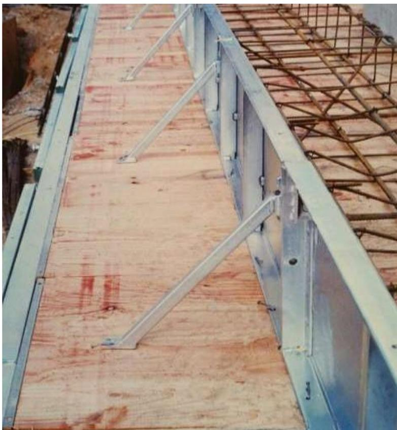
Figura 62 –Colocación de tabicas encofrado Fuente: elaboración propia
