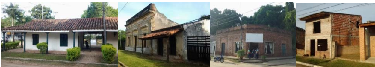
Fig. 3: Ejemplo de la evolución en los últimos 100 años de la edificación argentina: de construcciones con adobe y madera (izquierda) a las de cerámicos huecos, chapas y vidrio (derecha). De altas a bajas resistencias térmicas perimetrales de la edificación . Fuente: JACOBO, 2016 y 2017.
