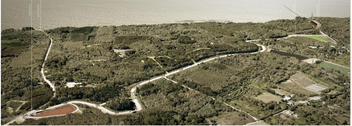
Figura 18. Paseo de la defensa costera. Vista aérea.
