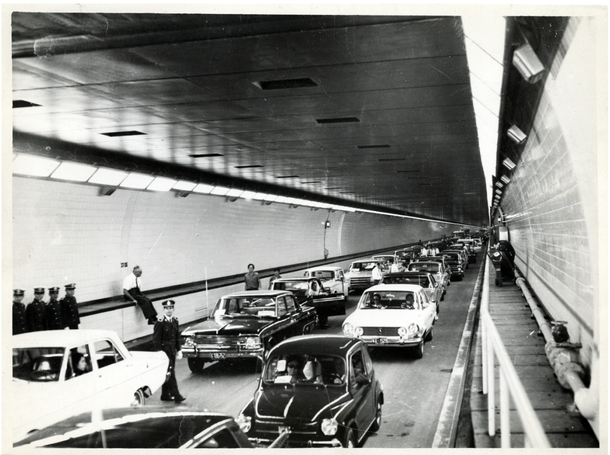
El interior del Túnel Subfluvial Hernandarias, hoy Uranga – Sylvestre Begnis.
