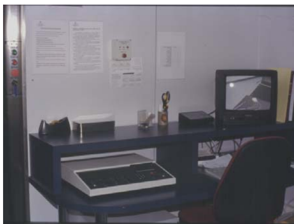
Figura 3.15. Sala de control.
