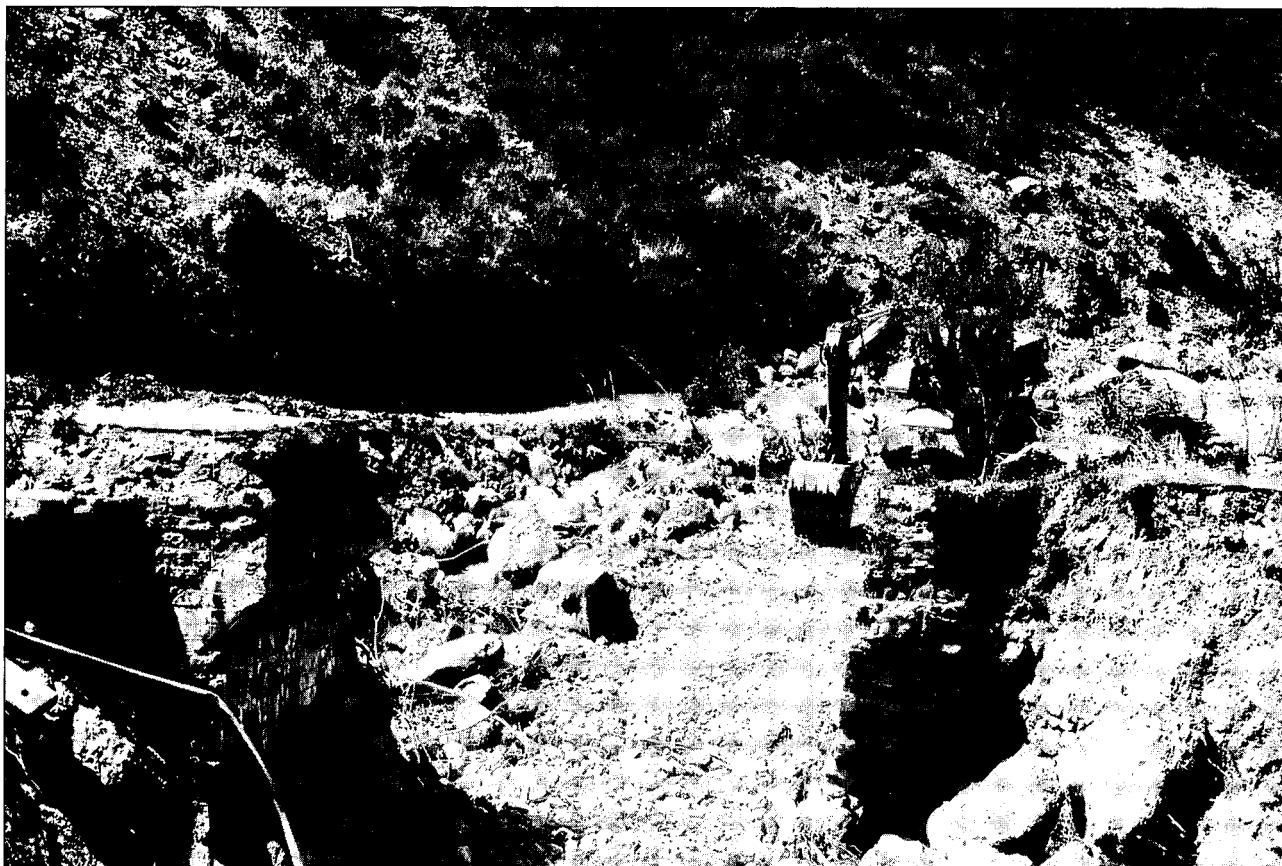
Foto 5.- Pont destruït en la confluència del Barranco de Aso i la carretera a Yosa de Sobremonte (Punt a en la figura 1)
