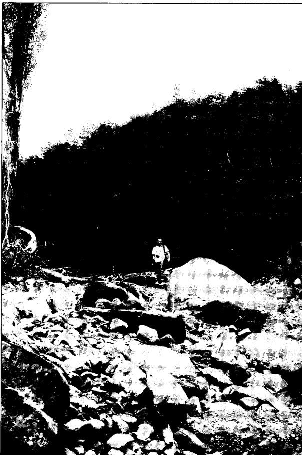
Foto 2.- Mobilització de material al Barranco de Betés en el pont de la carretera a Aso de Sobremonte (Punt b en la figura 1)
