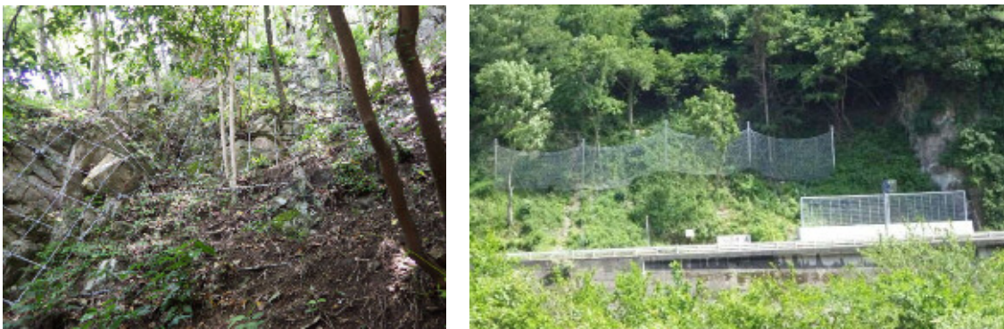
図 1.1.6 施工事例 落石予防工__ロープ伏工（左） 落石防護工__高吸収落石防護柵（右）
