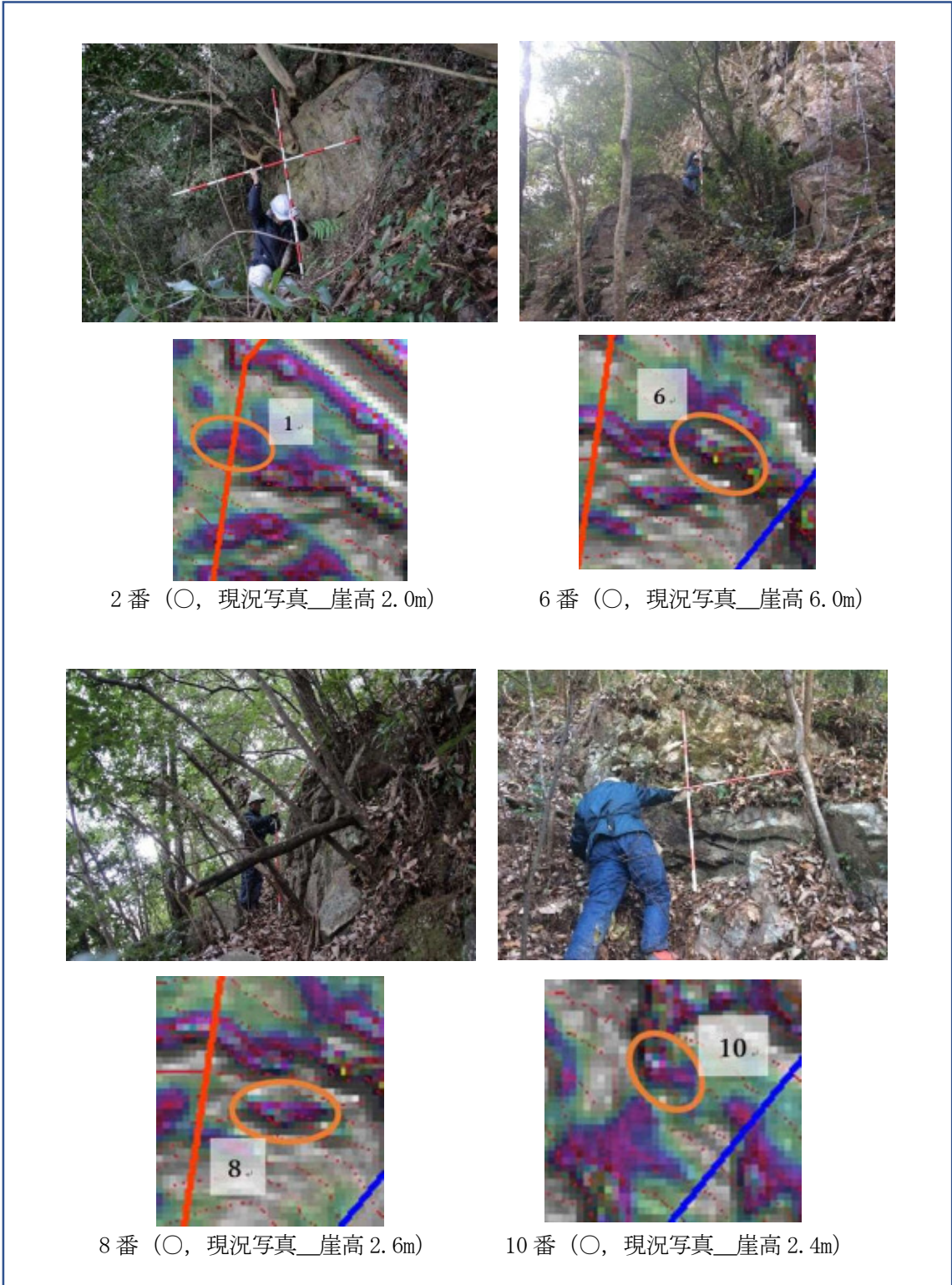
図 6.3.16 落石発生源抽出結果および現況写真 (エリア 3)
