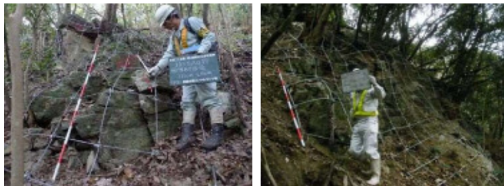
④ロープ伏工
