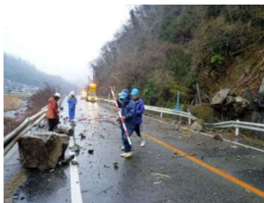
図1.1.2 落石被災写真（岡山県）
