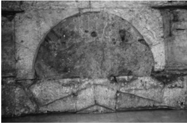
8 Rom, Kirche SS. Cosma e Damiano, Westwand mit sekundär zugesetztem Fenster
