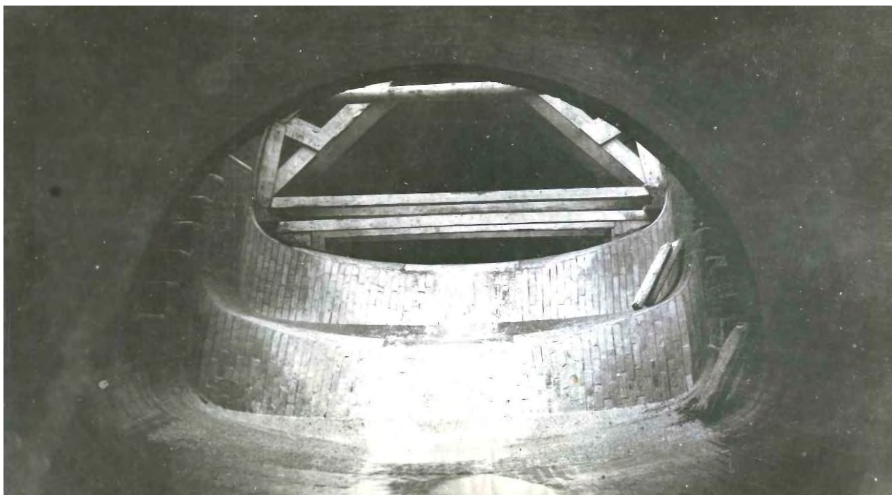
Fig. 9: Collettore di Ampliamento Est, «doppio salto a scivola in Via Caiazzo». Stampa su carta. Quindicesima fotografia dell'album: «Costruzione del Collettore Zona ampliamento Est Tratte da via Verrocchio a via Settembrini da via Sarmartini a via M. Gioia 1928-1931 VI-IX. - Impresa F. lli Battaini & C. Milano». Stampa su carta, Autore Mariani-Milano (Fondo fotografico storico Servizio Idrico Integrato MM SpA).
