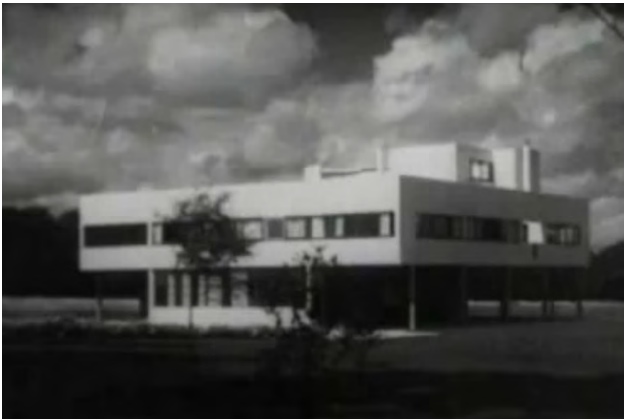
Fig. 1: La celebre villa Savoye di Le Corbusier in un fotogramma tratto dal documentario L'Architecture d'aujourd'hui , di Pierre Chenal (1930). Il suo disegno esprime al meglio i Cinque Punti del Movimento Moderno: pilotis; tetto-giardino; pianta libera; finestre a nastro; facciata libera da condizionamenti strutturali.
