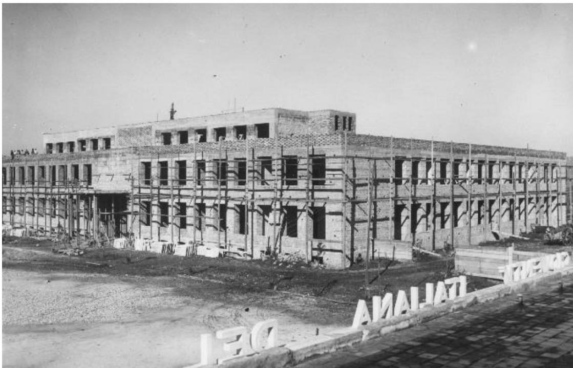
Figg. 2-3: L. Intorcia, Edificio scolastico G. Mazzini opera dell'architetto F. Frediani (1934-37), Benevento, piazza della Rivoluzione (Archivio Gennaro De Rienzo, album 44); L. Intorcia, Liceo P. Giannone opera dell'architetto L. Piccinato (1938), Benevento, piazza della Rivoluzione (Archivio Gennaro De Rienzo, album 44).
