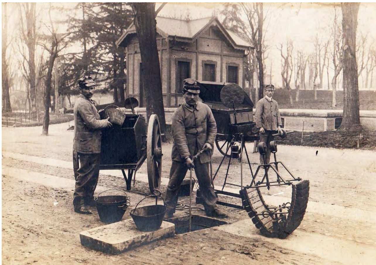
Fig. 3: La centrale Parini e, in primo piano, gli addetti manutenzione dei condotti fognari. Autore non identificato, stampa su carta, 1910 ca. (Fondo fotografico storico Servizio Idrico Integrato MM SpA).
