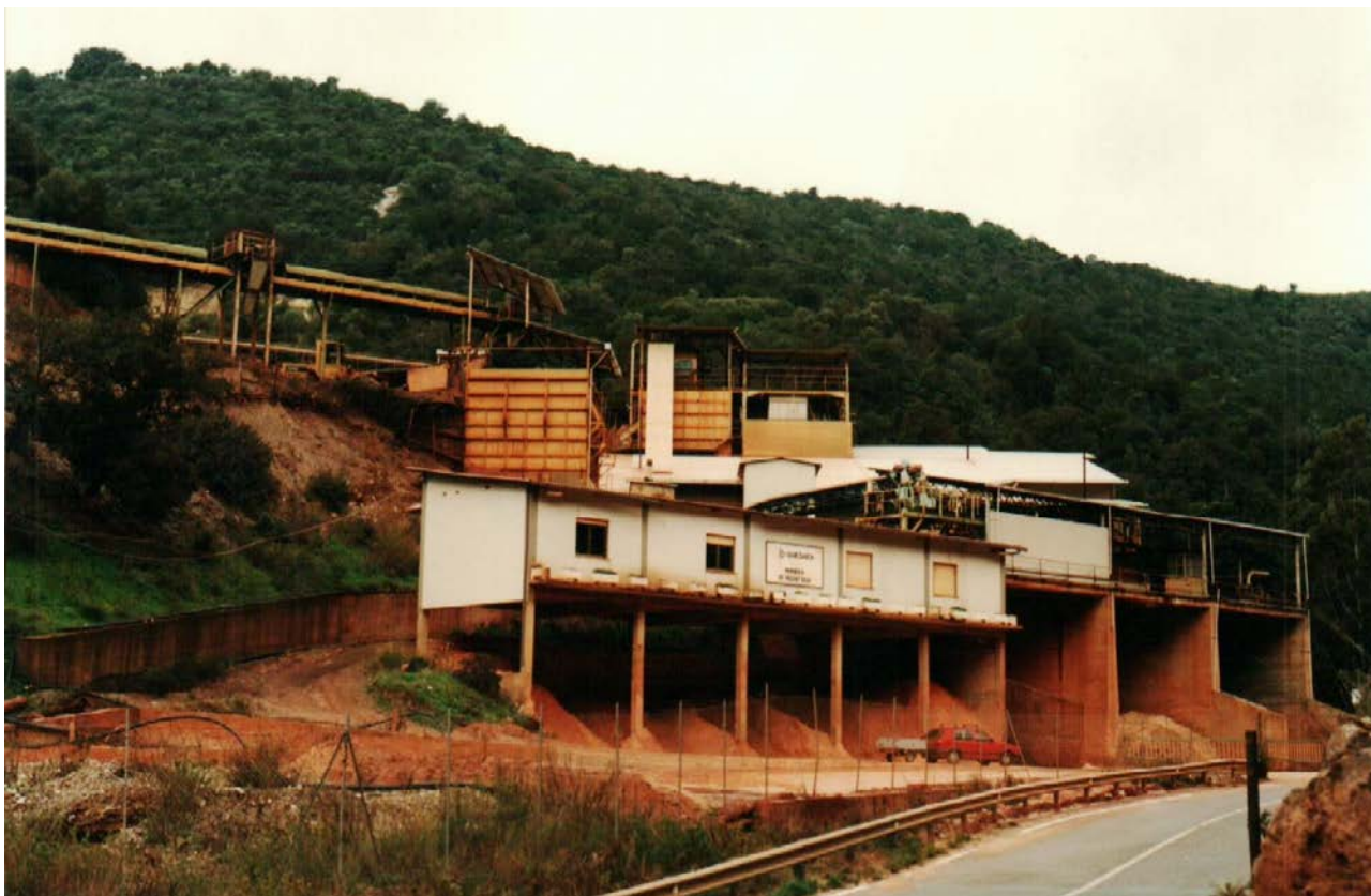
Fig. 3: Miniera di Mont'Ega, Laveria Meccanica (1976). Archivio Fotografico Soprintendenza Beni Architettonici, Paesaggistici, Artistici ed Etnografici delle Province di Cagliari e Oristano.
