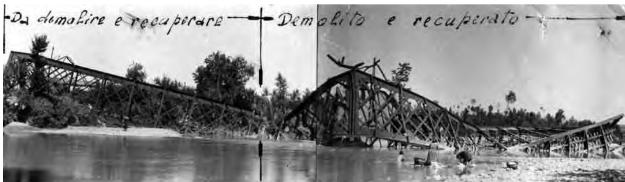
Fig. 6: Demolizione e recupero delle travate del ponte della ferrovia sul fiume Tevere, Perugia 1945 (Archivio Privato).
