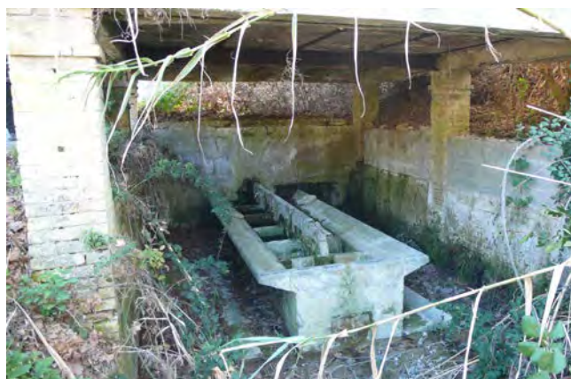
Fig. 3: Massignano, provincia di Ascoli Piceno. Lavatoio comunale.
