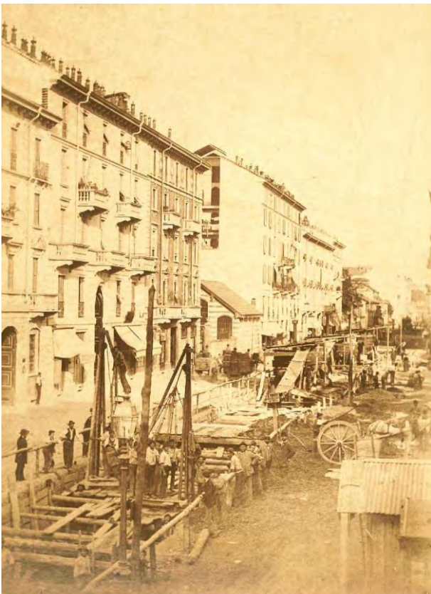
Fig. 7-8: Cantiere per la realizzazione del collettore di Vigentino in viale Ludovica a Milano. Stato dei lavori nell'autunno del 1893. Autore non identificato, stampa su carta (Fondo fotografico storico Servizio Idrico Integrato MM SpA).
