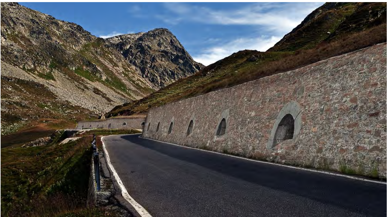
Fig. 5: La strada dello Spluga e le gallerie paravalanghe. Foto di Franco Papetti.
