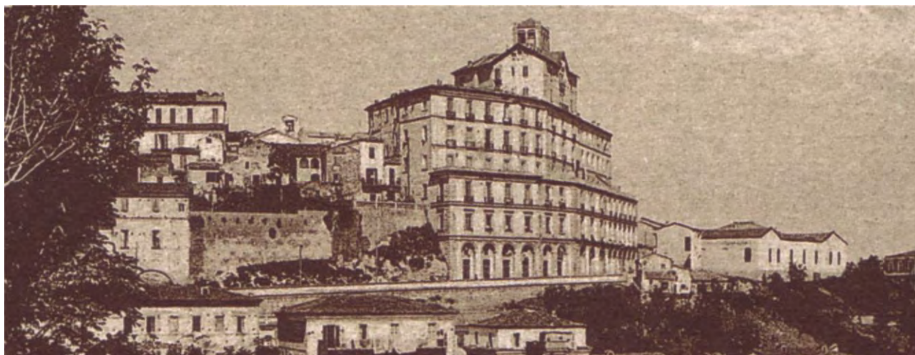
Fig. 6: Immagine fotografica del palazzo Mezzanotte dopo il completamento, inizio XX secolo (collezione Mezzanotte).
