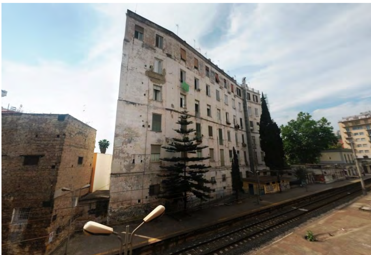
Fig. 9 : Napoli, lato posteriore dell'edificio appartenuto alla famiglia Pontillo al corso Vittorio Emanuele n. 84.
