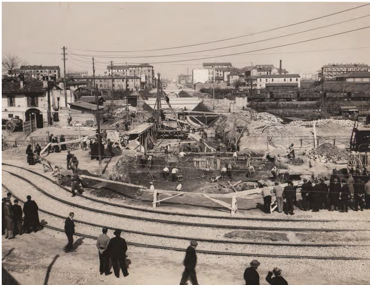
Fig. 1: Nuovo alveo dell'Olona. Costruzione dell'attraversamento col naviglio Grande. Autore Luigi Stucchi Milano, stampa su carta, s.d. (Fondo fotografico storico Servizio Idrico Integrato MM SpA).
