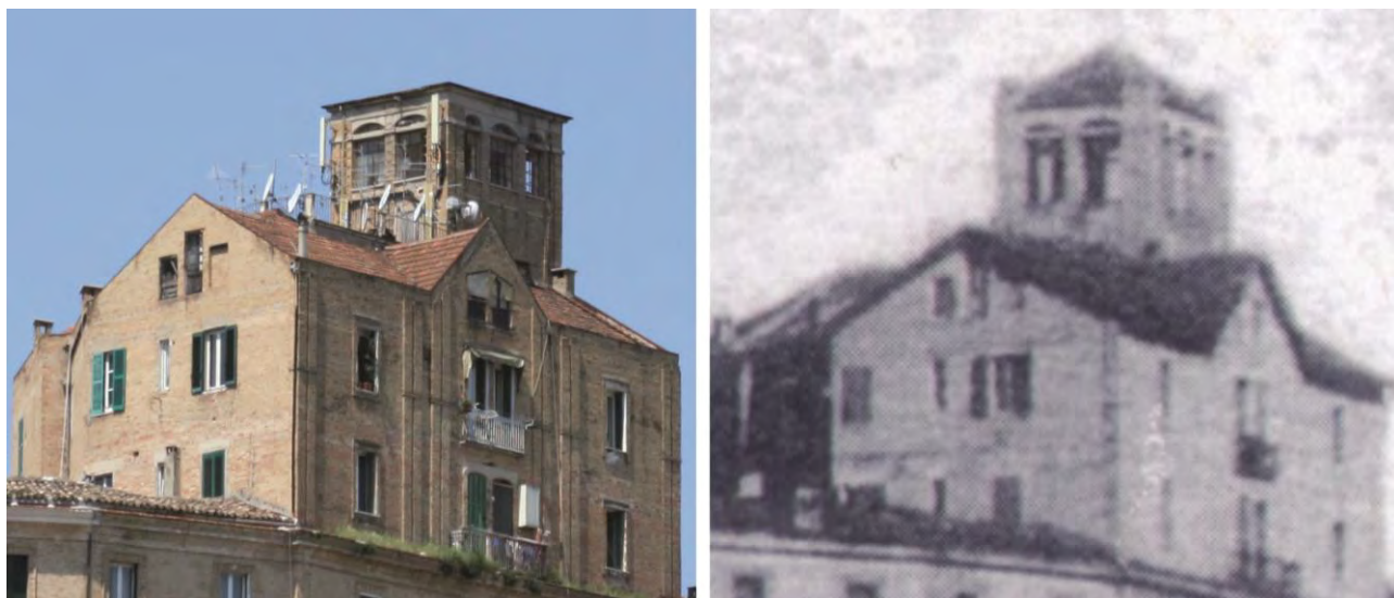
Fig. 9: La torre belvedere del palazzo Mezzanotte, confronto fra: a) Stato di fatto attuale; b) Conformazione originaria. Fotografia di inizio XX secolo, particolare (collezione Giorgio Cornacchia).
