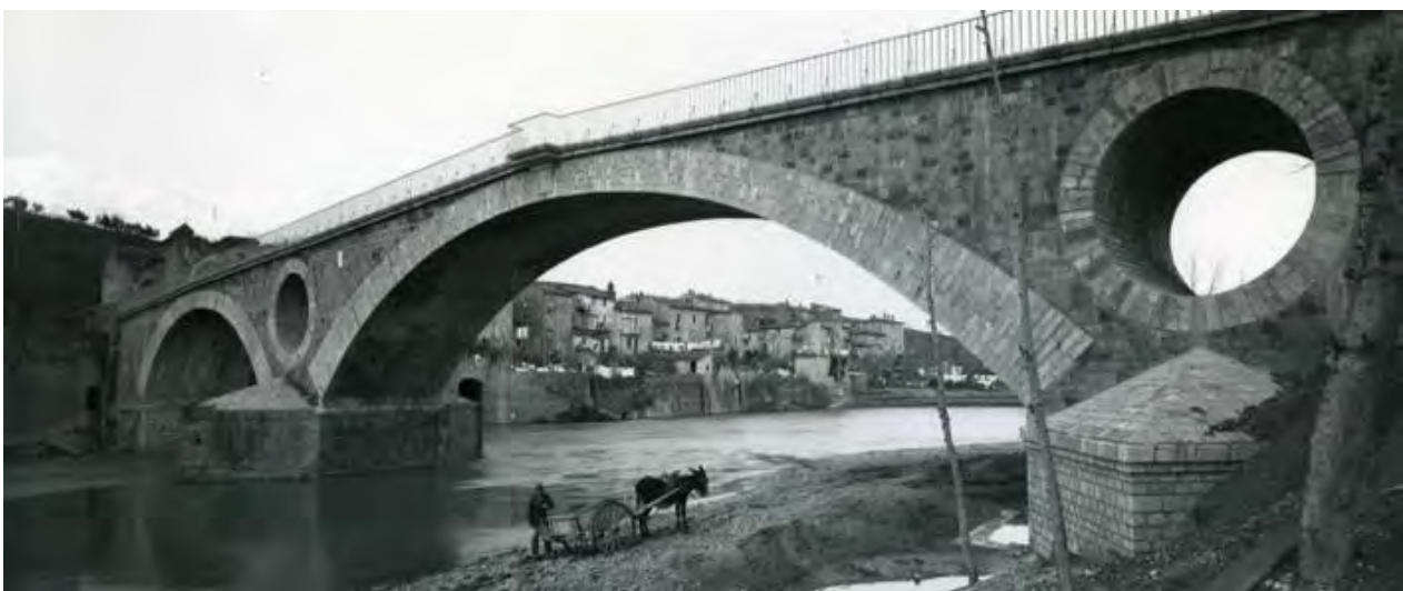
Figg. 1 - 2: Ricostruzione del ponte sul fiume Tevere a Ponte Felcino, Perugia, 1946 (Archivio Privato).
