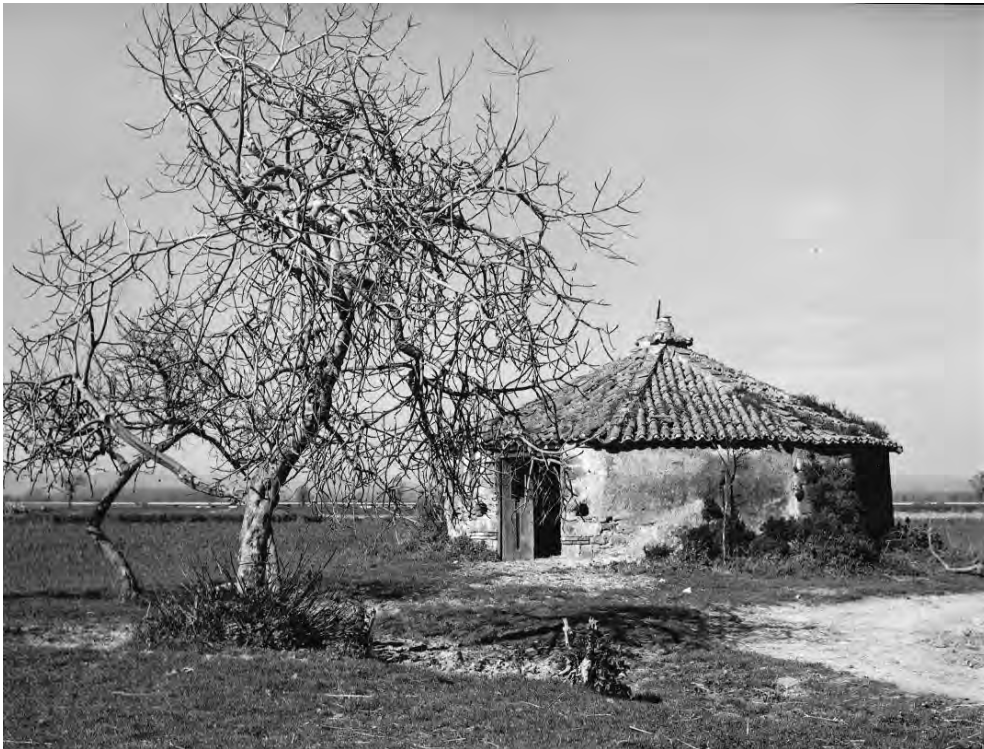
Fig. 3: R. Pane, Casa rurale campana, anni '40. (Archivio fotografico Roberto Pane, Dipartimento di Architettura Università degli Studi di Napoli Federico II, Inv. 1/A1.41).
