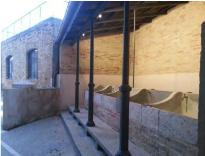
Fig. 8: Carassai, Lavatoio comunale (1901).
