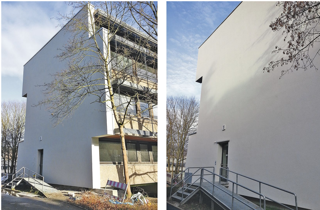
Bild 15. Fotos der sanierten Fassade, in der Mitte ist die Außenklappe für die Feldtestfläche der aLT erkennbar Fig. 15. Pictures of the renovated façade, in the middle the outer flap for the field test area of the aLT is visible
