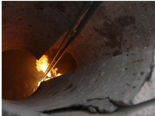
**Abbildung 8.8:** Durchführung der Schädigung #3 - Durchtrennen der externen Spannglieder [SCH-11]
