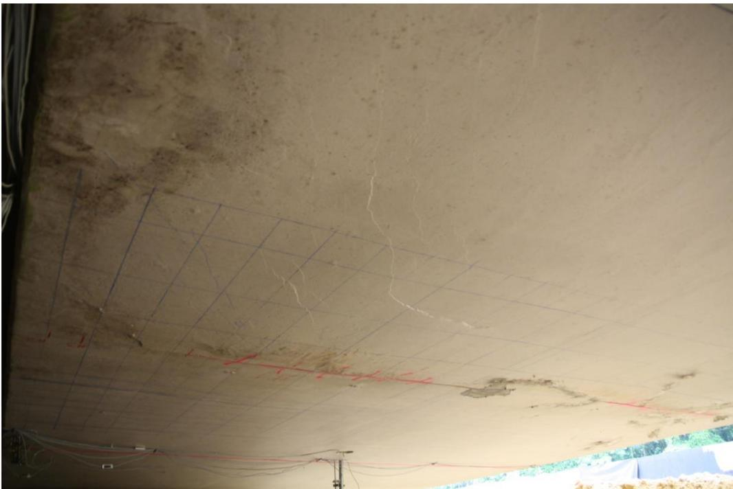
**Abbildung 8.20:** Weitere Schubriss in der Bodenplatte im Bereich  $x = 0.45 L$  in Schädigungsstufe #3 [SCH-11]
