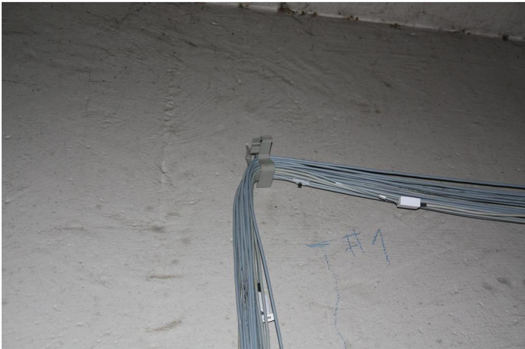
**Abbildung 8.21:** Anwachsen des Biegerisses in der Seitenwand des Hohlkastens an der Stelle  $x = 0.45 \text{ L}$  in Schädigungsstufe #3 [SCH-11]
