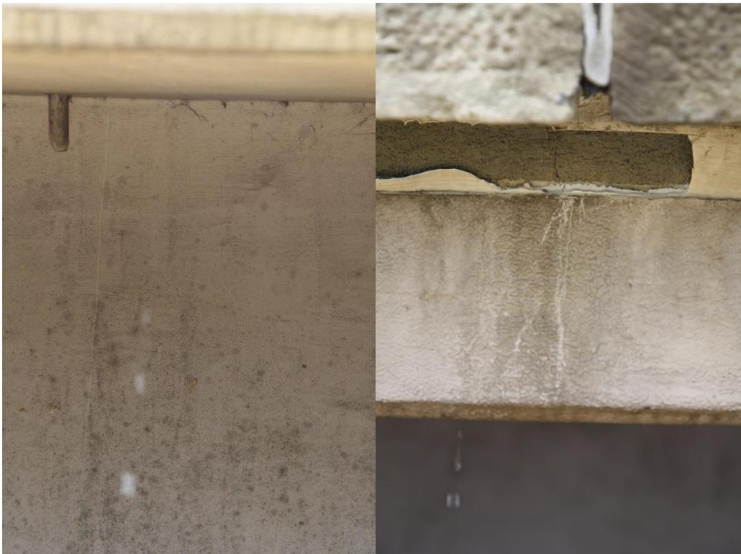
**Abbildung 8.24:** Rissbildung in der Fahrbahnplatte im Bereich des Pfeilers in Schädigungsstufe #4 unter Eigengewicht [SCH-11]
