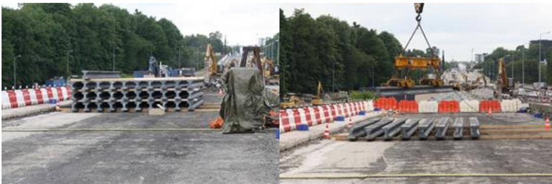
**Abbildung 8.9:** Stahlträger zur Aufbringung der Versuchslast - links: 31 der 38 Stahlträger; rechts: Auflegen der Stahlträger auf die Brücke mittels Elektromagneten [SCH-11]
