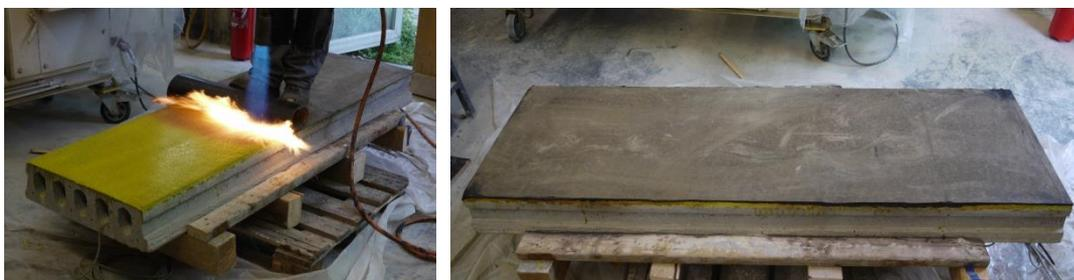
**Abbildung 4.4:** Betonplatte mit aufgebrachtener Abdichtung; links: Aufbringen der Bitumen-Schweißbahn; rechts: Platte mit fertiger Abdichtung
