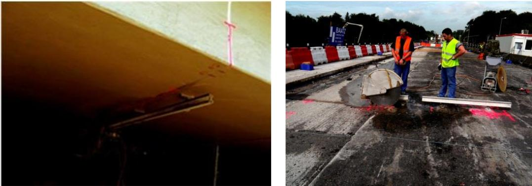
**Abbildung 8.7:** Durchführung der Schädigungen - links: Führungsschiene der Betonsäge für Schädigung #1 an der Unterseite der Brücke montiert; rechts: Durchführung der Schädigung #2 bzw. #4 [SCH-11]
