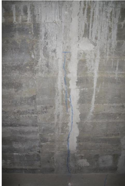
**Abbildung 8.19:** Biegerisse in der Seitenwand des Hohlkastens an der Stelle  $x = 0.45 L$  für die Schädigungsstufe #1-L (Brücke belastet) [SCH-11]
