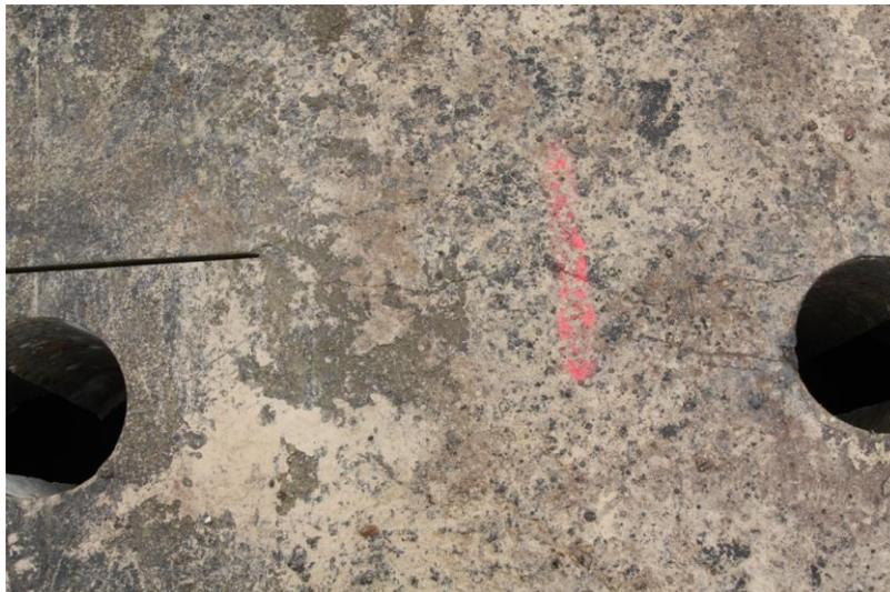
**Abbildung 8.22:** Entstehung kleiner Risse zwischen den Bohrlöchern in der Fahrbahnplatte in der Nähe des Pfeilers in Schädigungsstufe #3-L [SCH-11]
