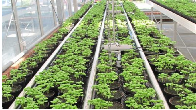
Abb. 4: Tisch mit Heizrohren im Bestand in der Gewächshauskabine
