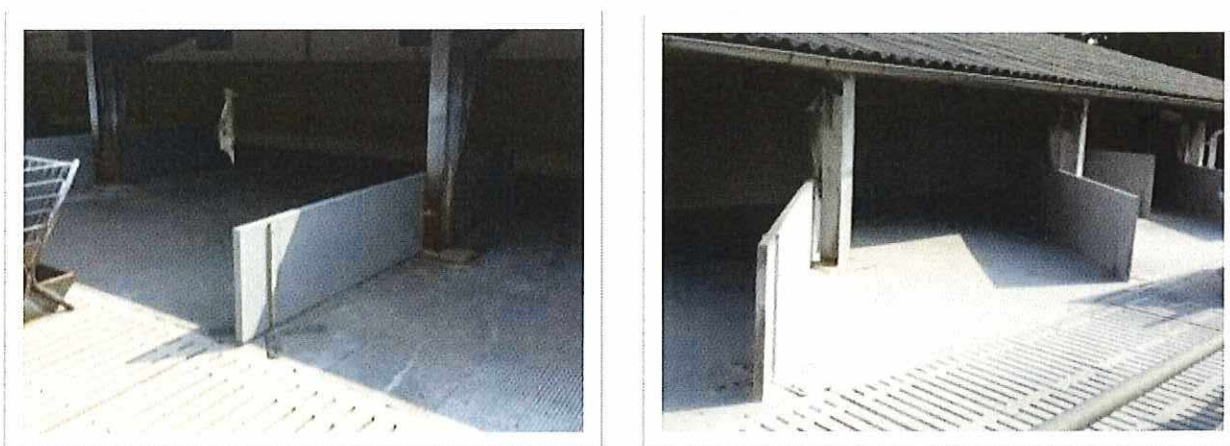
Figur 1. Venstre billede nordvendt sti med lige liggevægge. Væggene målte l: 4 m og h: 60 cm. Højre billede sydvendt sti med skrå liggevægge. Væggene målte l: 5 m og h: 80 cm. Væggene var i begge stier placeret på arealet med fast gulv.
