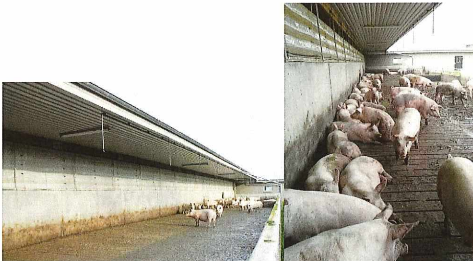
Figur 2. Udeareal som stalden så ud før iværksættning af forsøgs-tiltag. Udearealet målte 39,6 m x 6 m og betongulvet bestod af en kombination af drænet gulv og spaltegulv. Taget dækkede halvdelen af udearealet (3 m). Der er en plantegning i figur 4, som viser placering og fordeling af drænet gulv henholdsvis spaltegulv. Grisene blev ofte set ligge op ad bygningen under tagdhænget.
