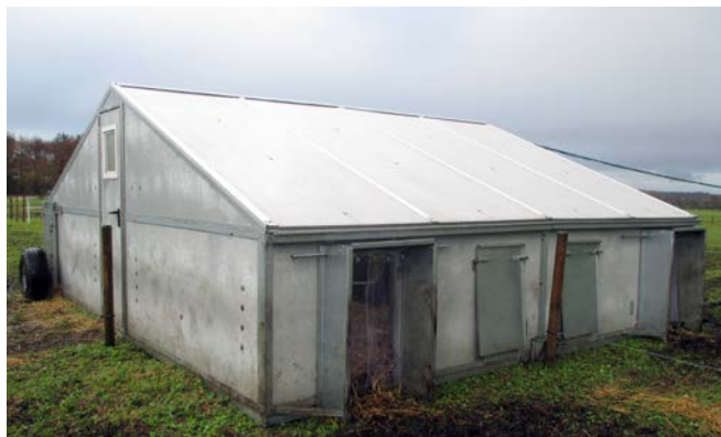
Storhytte med overdækning. Foto: Lene Thomsen
