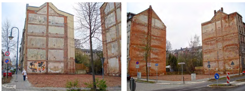
Ryc. 12. Przykłady wyburzenia zabudowy śródmiejskiej (fot. A. Radzimski)
