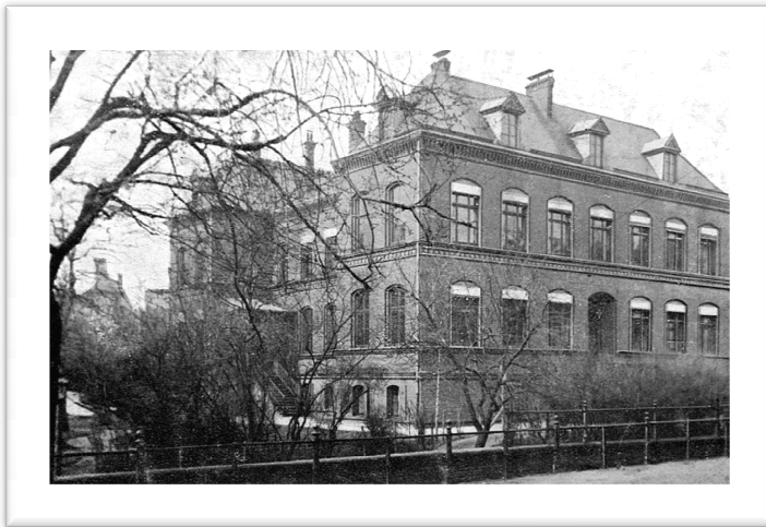
Abbildung 18: Das alte Chemische Institut, in dem die Labore der Pharmazie im linken Keller sowie im Erdgeschoss lagen
