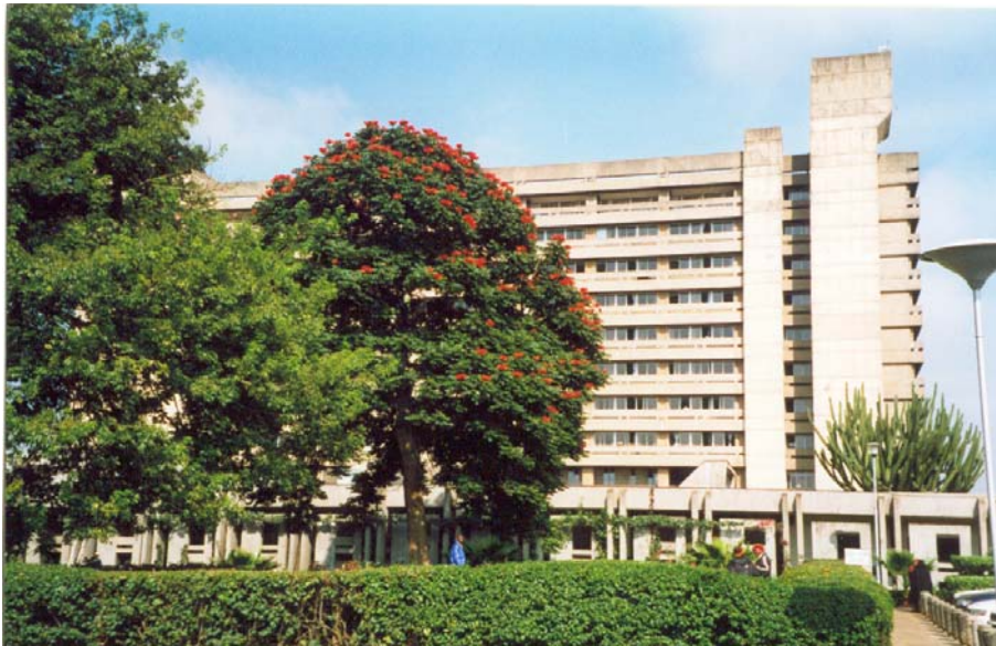
Abb. 2: Rückansicht des Kenyatta National Hospital
