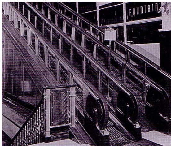
18 Rolltreppe der Firma Otis mit Glasbalustrade. Anfang 20. Jahrhundert. Fotografie aus einer Firmenschrift, um 1975.
