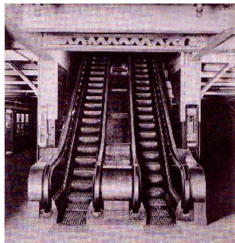
54 Seeberger- / Otis-Rolltreppe in der Times Square Station der New Yorker Untergrundbahn. Um 1910. Fotografie aus dem „Escalatoren“ - Katalog der Firma Otis, 1929.
