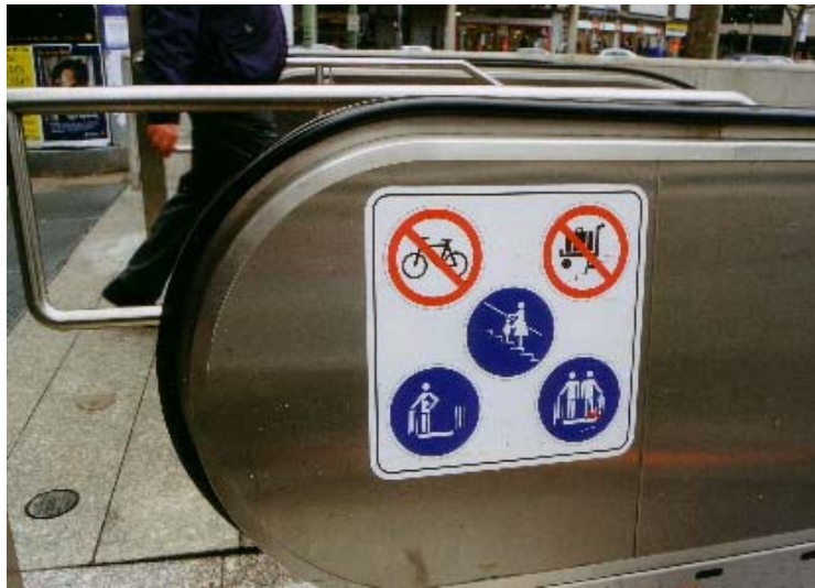
108 Piktogramme an der Balustrade einer Rolltreppe des Frankfurter Hauptbahnhofes. Hinweisaufkleber, 2005.
