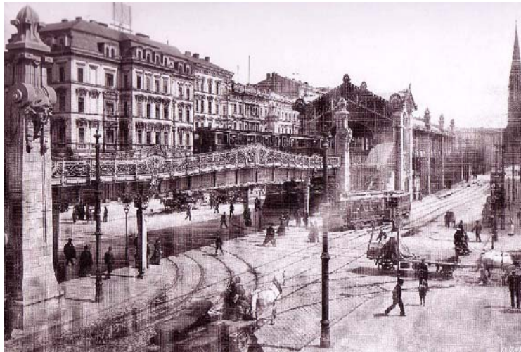
62 Viadukt und Bahnhof Bülowsstraße, Berlin. Fotografie 1902.
