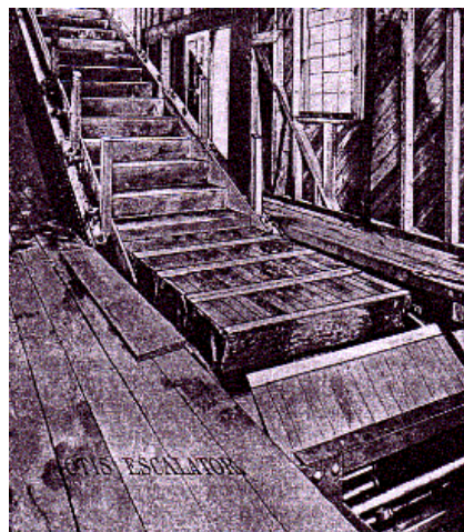
12 „Otis-Escalator“ mit hölzernen Stufen ohne Rillen. Grafik aus einem Bericht über die Weltausstellung in Paris, 1901.
