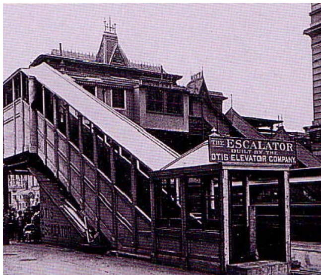
52 Überdachte Seeberger-/Otis-Rolltreppe an der New Yorker Hochbahn 1900. Fotografie aus einer Firmenschrift, um 1975.
