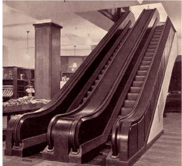
17 Fahrtreppe der Firma Carl Flohr mit vollwandiger Holzverkleidung. Berlin 1920er Jahre. Fotografie aus einer Firmenschrift, 1929.
