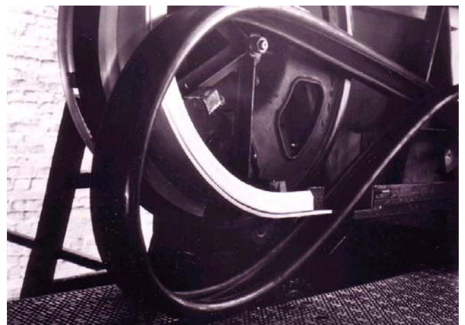
23 “Installing handrail on the newel stands”, Fotografie, um 1970.
