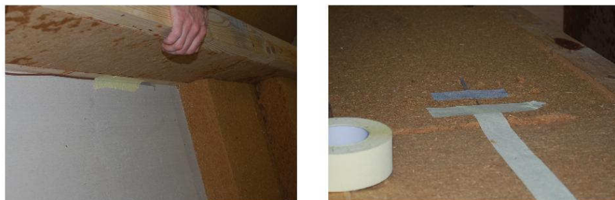
Obr. 20: Zabudování teplotně-vlhkostních čidel do panelu obvodové stěny
