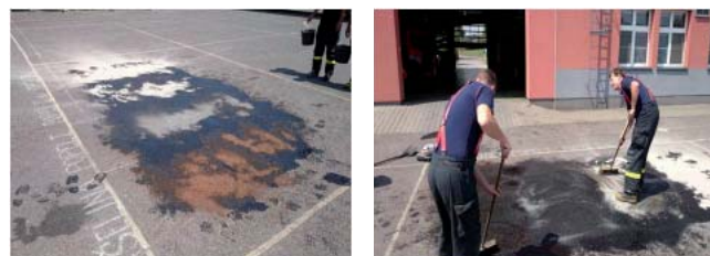
Obr. 3-4 Odstraňování ropných produktů a stanovení spotřeby test. popelů a rašeliny
